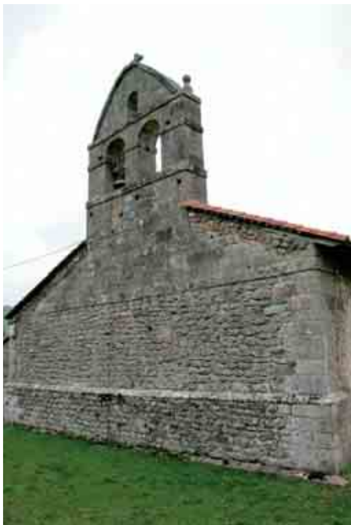
Primer plano de la espadaña con las dos troneras de medio punto
