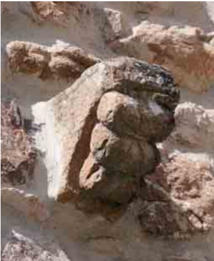
Canecillo de rollos incrustado en la fachada
