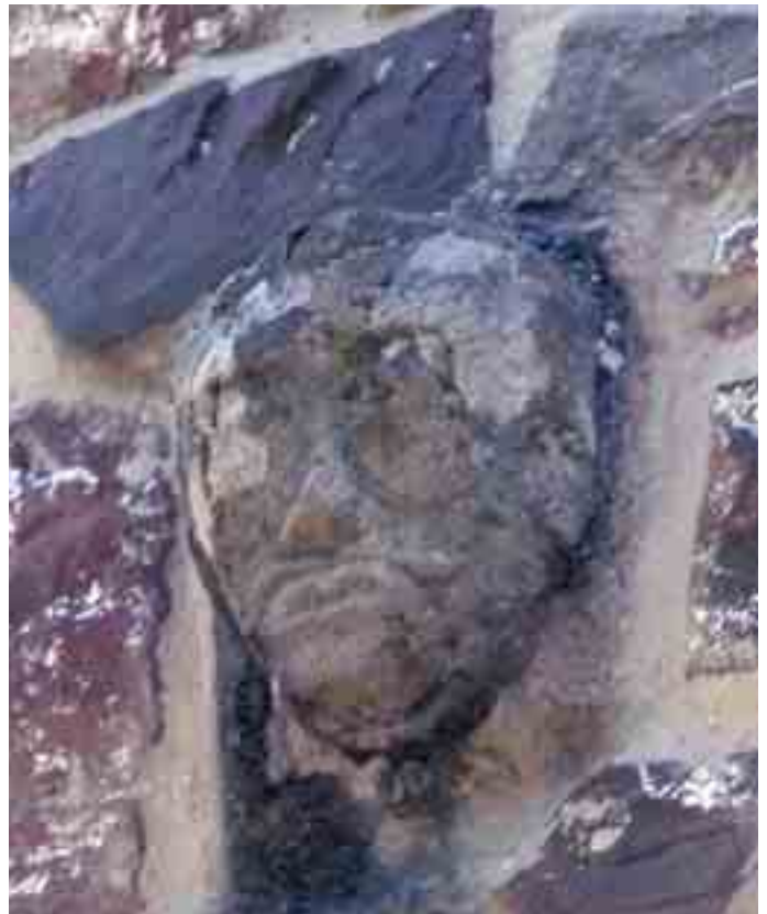
Rostro humano incrustado en la fachada
