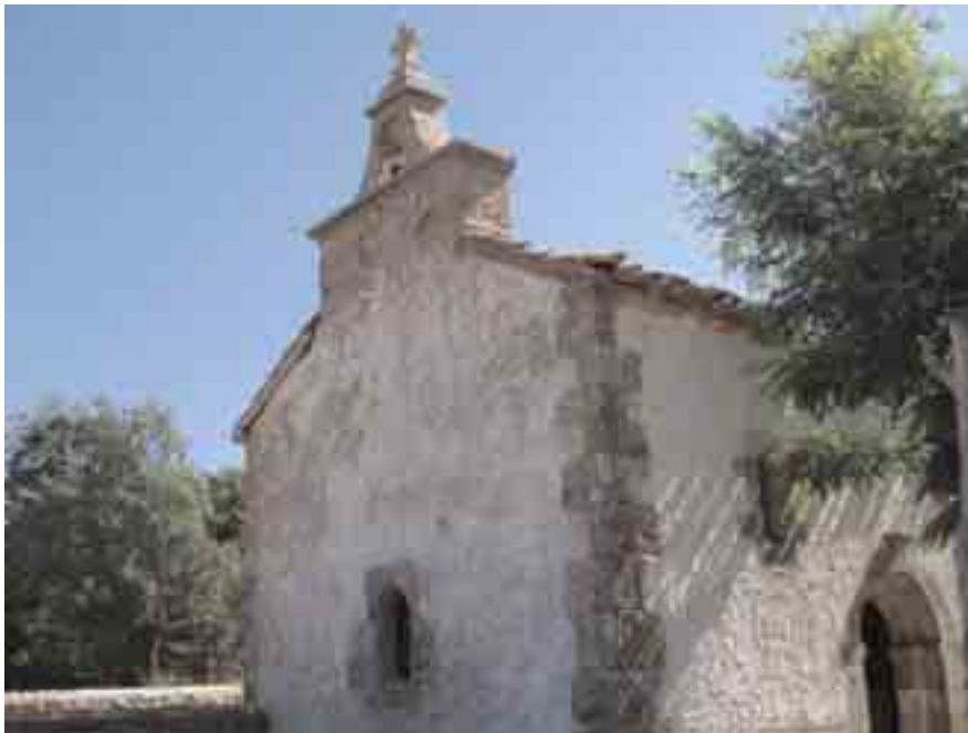
Vista de la ermita de Santa Ana desde el Suroeste
