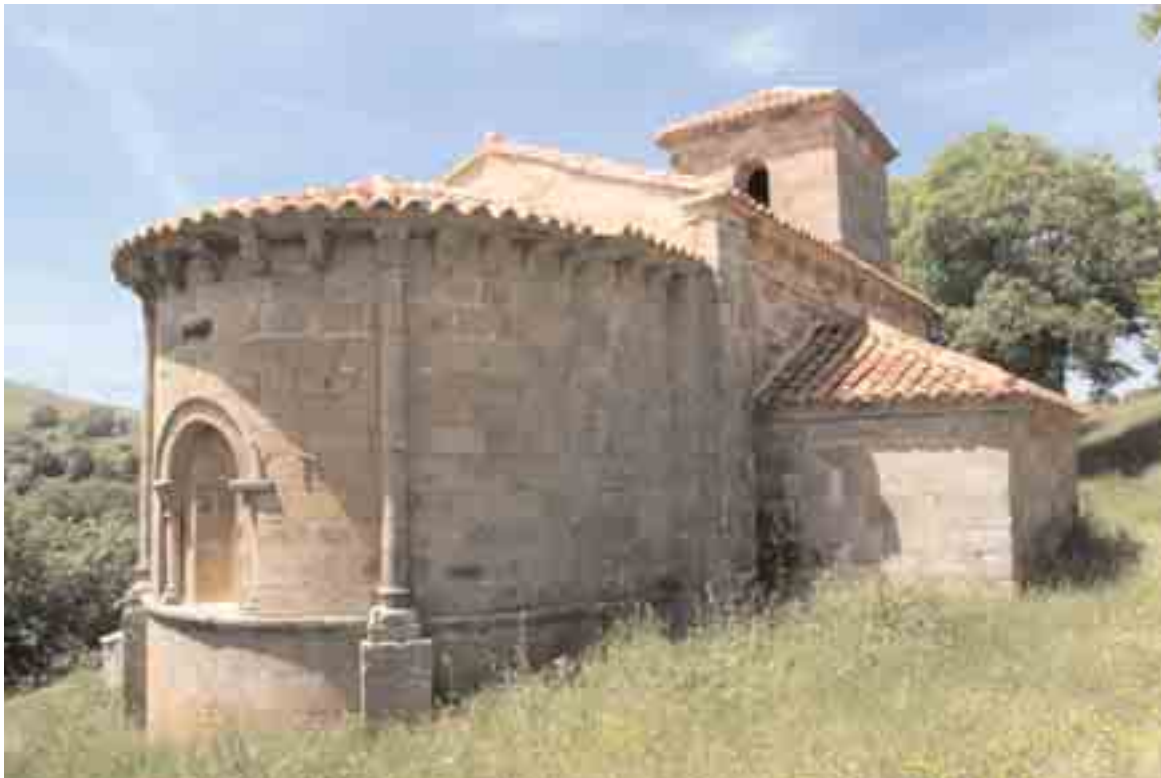
Aspecto general de la iglesia, desde el NE. Organización del ábside con sus columnas, fustes y basas
