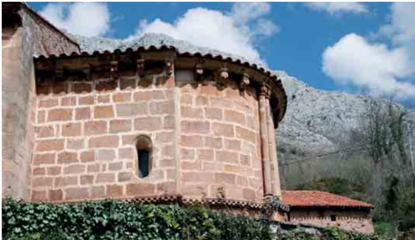
Vista del ábside con algunos de sus canecillos
