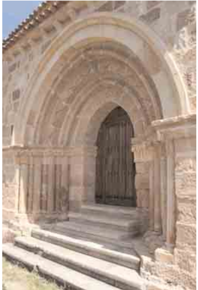
La monumental entrada del muro meridional, con la chambrana restaurada
