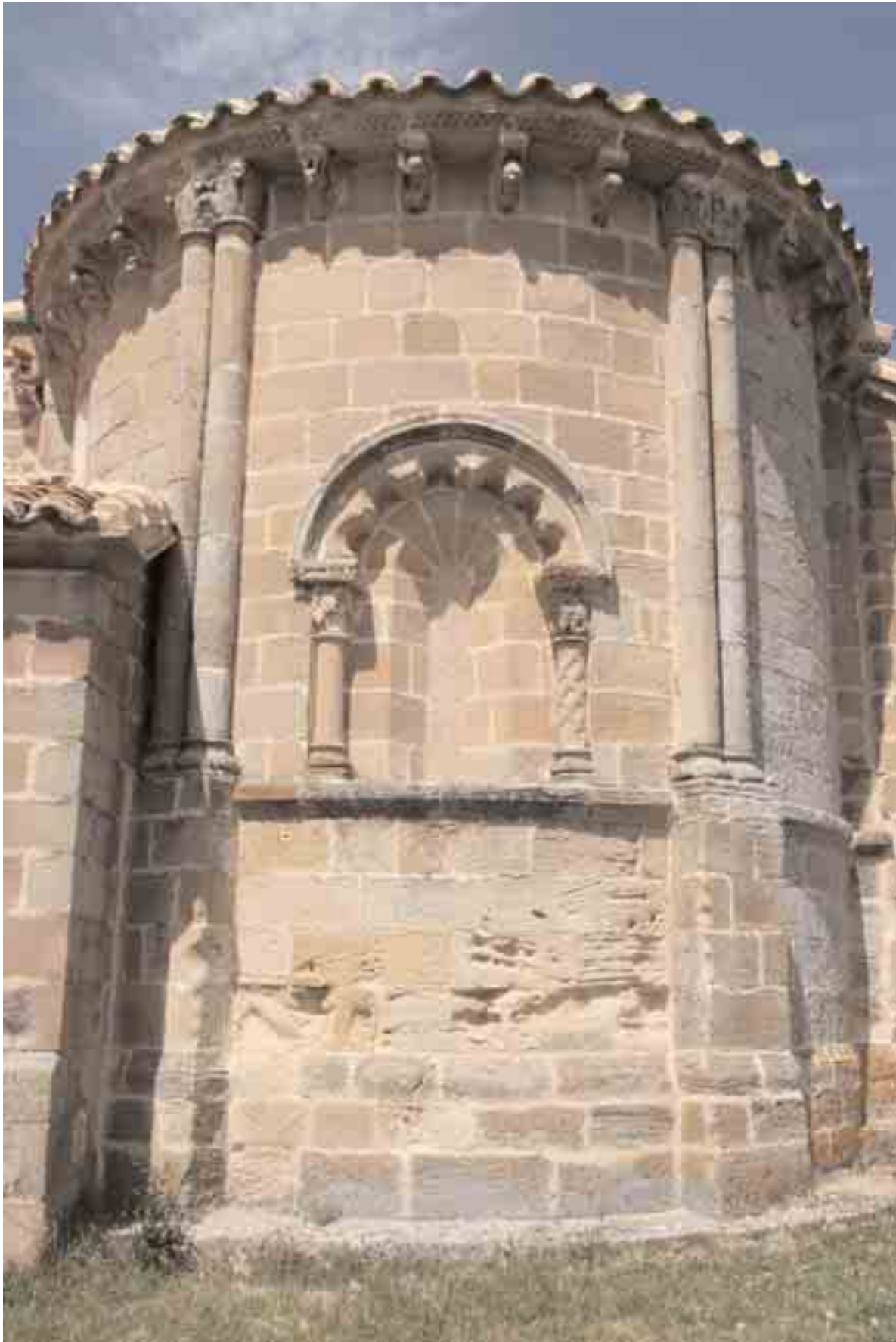
Aspecto total del ábside con las tres calles y sus canecillos, y ventana de la central.
