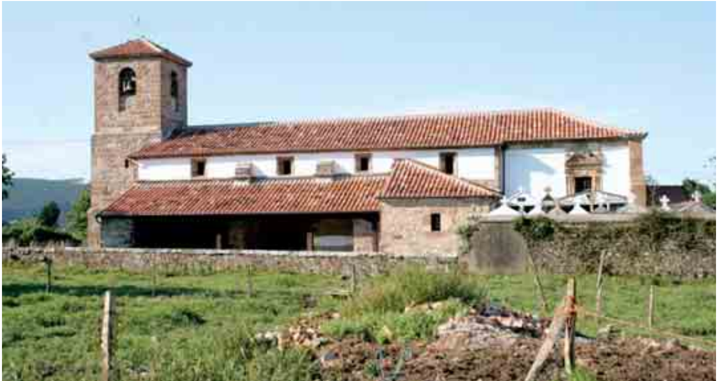
Vista general de la iglesia
