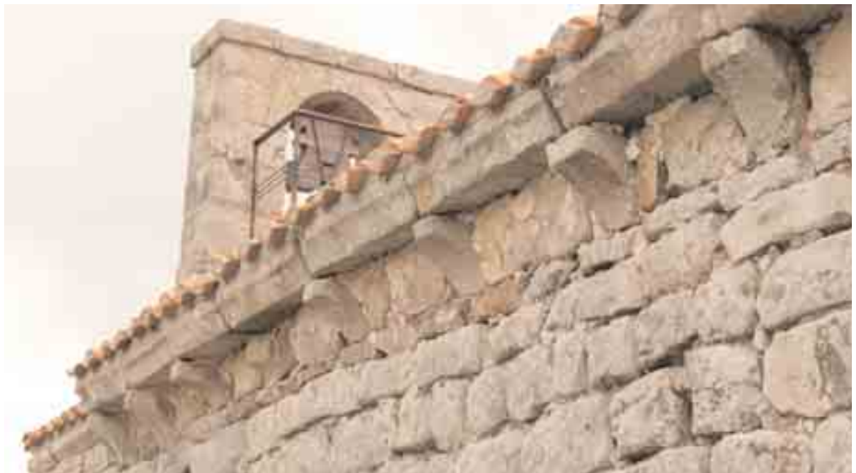
Espadaña, cornisa y canecillos (7) del muro norte
