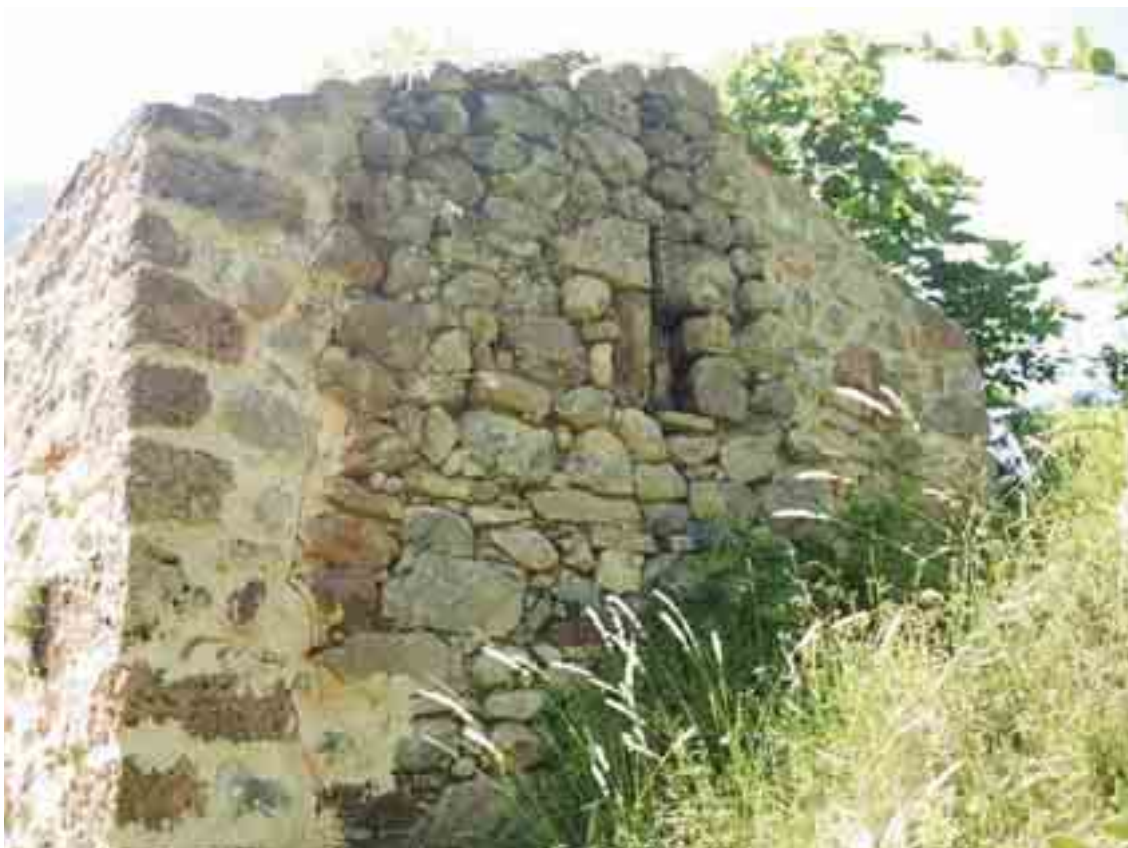
Vista de la cabecera desde el Sur
