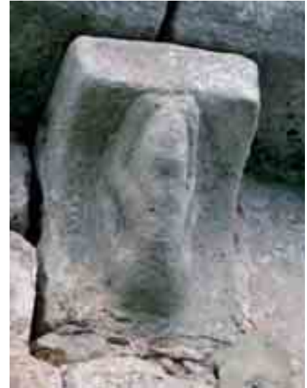
Canecillo 4 del ábside
