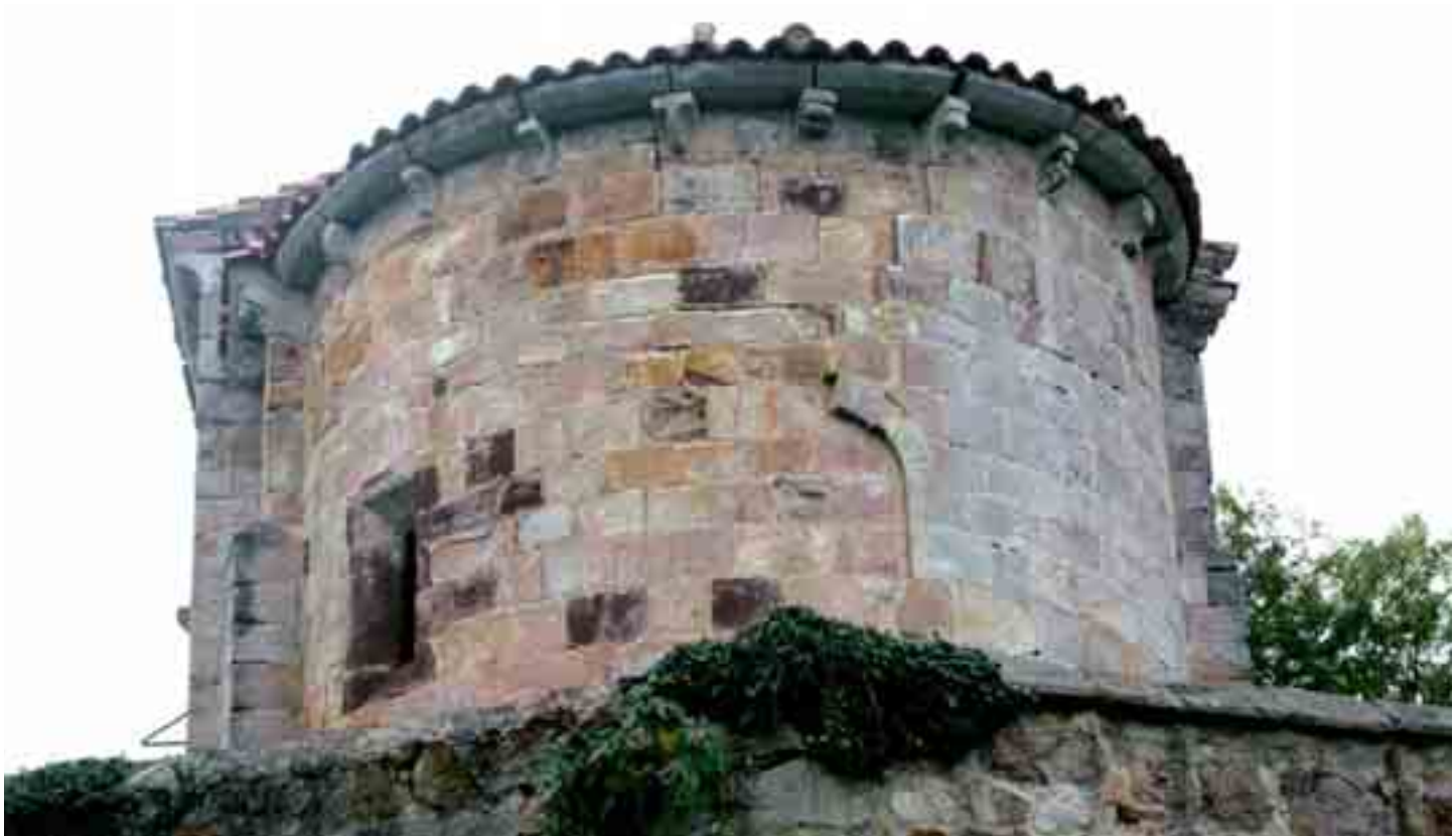
Conjunto del ábside, con la cornisa y canchillos
