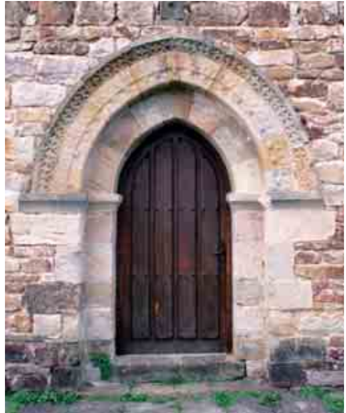
Puerta meridional con su chambrana y arquivoltas
