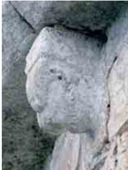
Canecillo 1 del ábside
