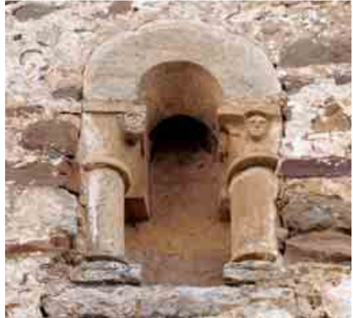
Ventana colocada en el ábside
