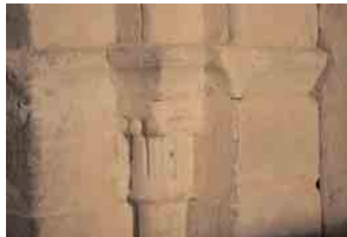
Cimacios y capiteles de los laterales izquierdo y derecho de la puerta
