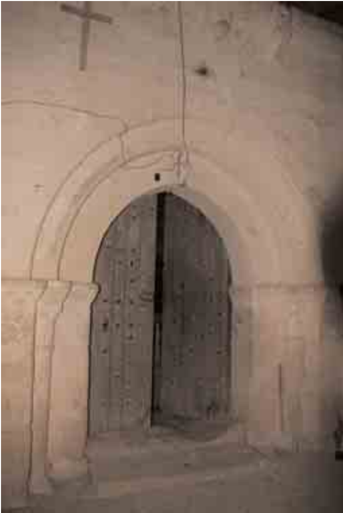
Puerta románica de entrada a la nave
