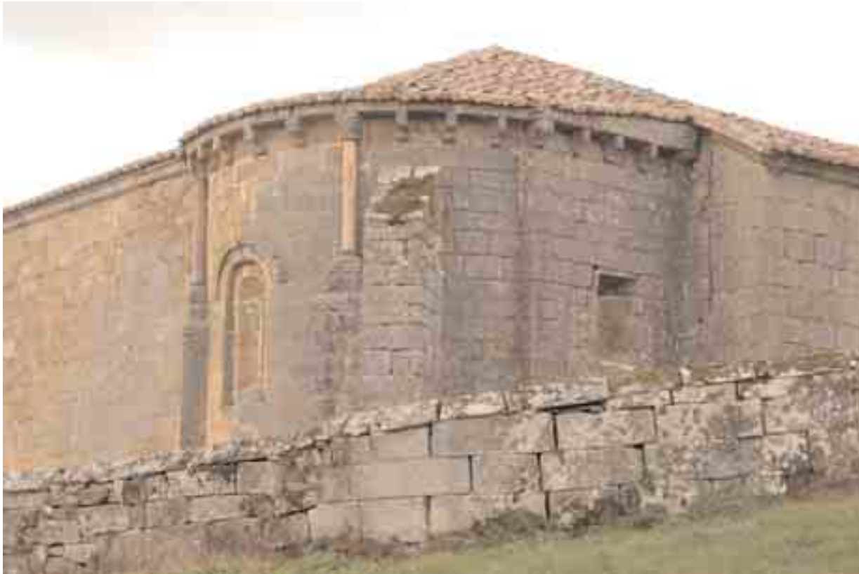
Conjunto visible del ábside
