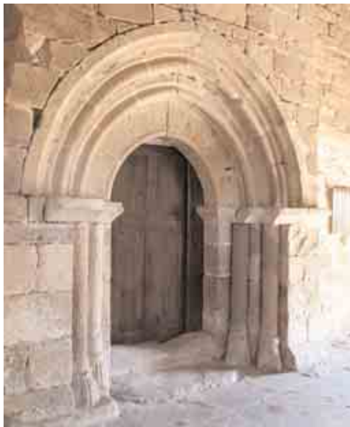
Puerta, dentro del pórtico, que da paso a la nave
