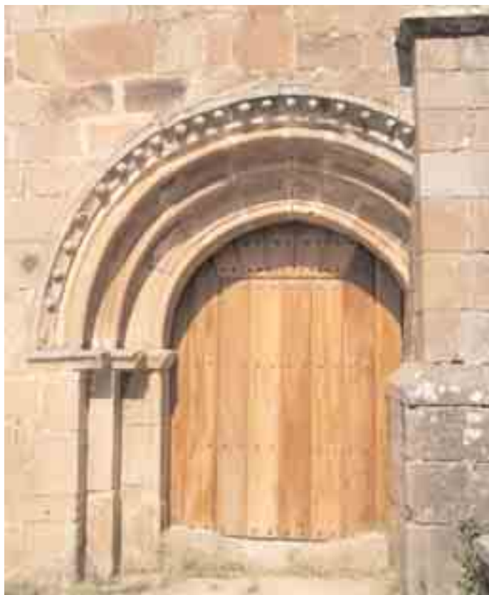
Detalle de la puerta que se abre al pórtico
