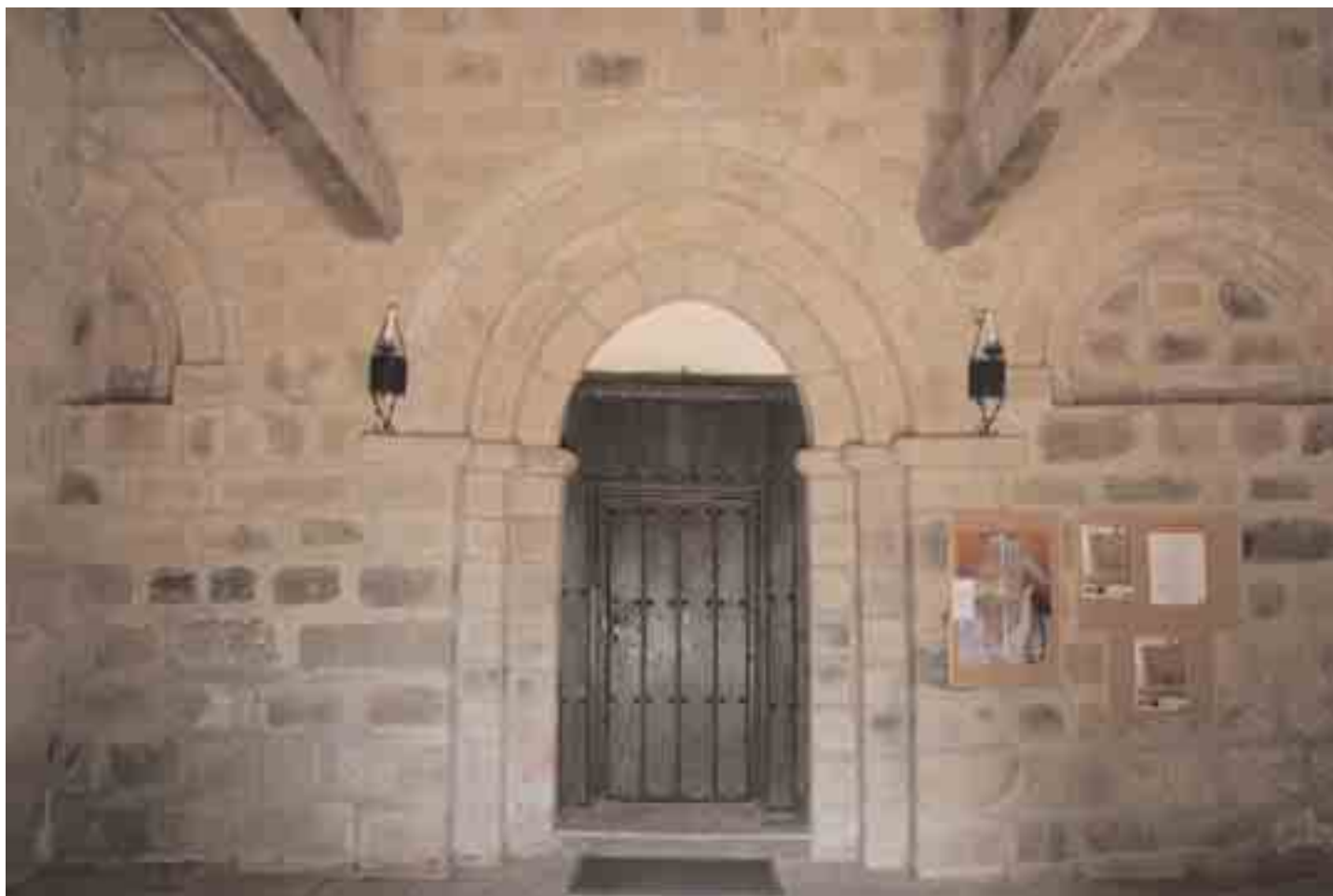
Fachada del muro sur, con la puerta y los arcosolium
