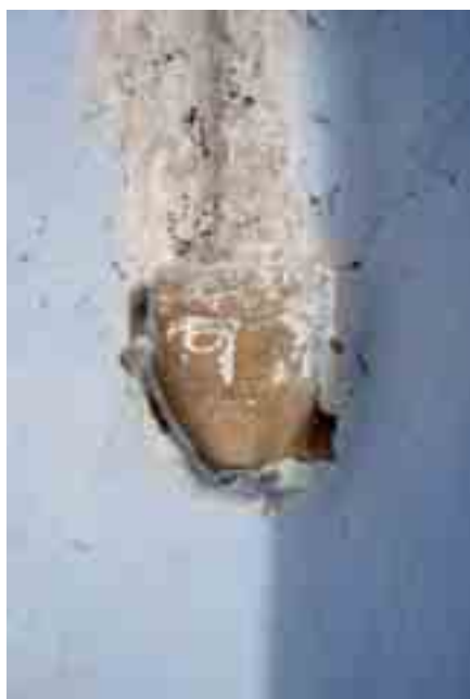
Ménsulas de las que arrancan los nervios angulares de la bóveda del ábside
