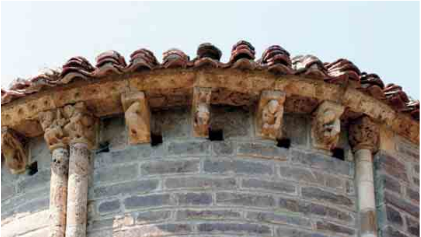
Ábside central. Calle lateral noreste
