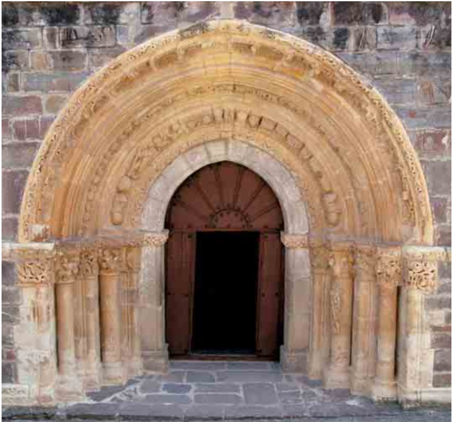
Puerta oeste o principal
