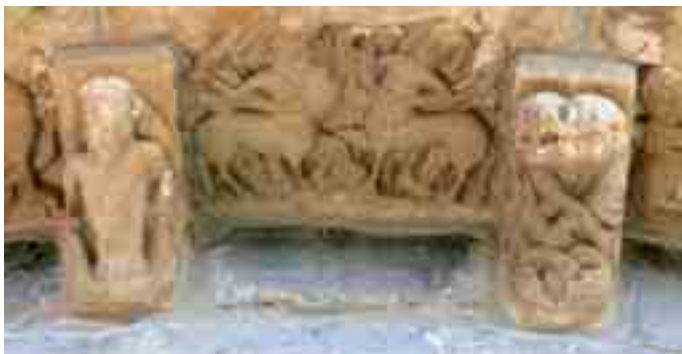
Canecillos 2 y 3, y metopa 3 del ábside central (lateral izquierdo o sureste)
