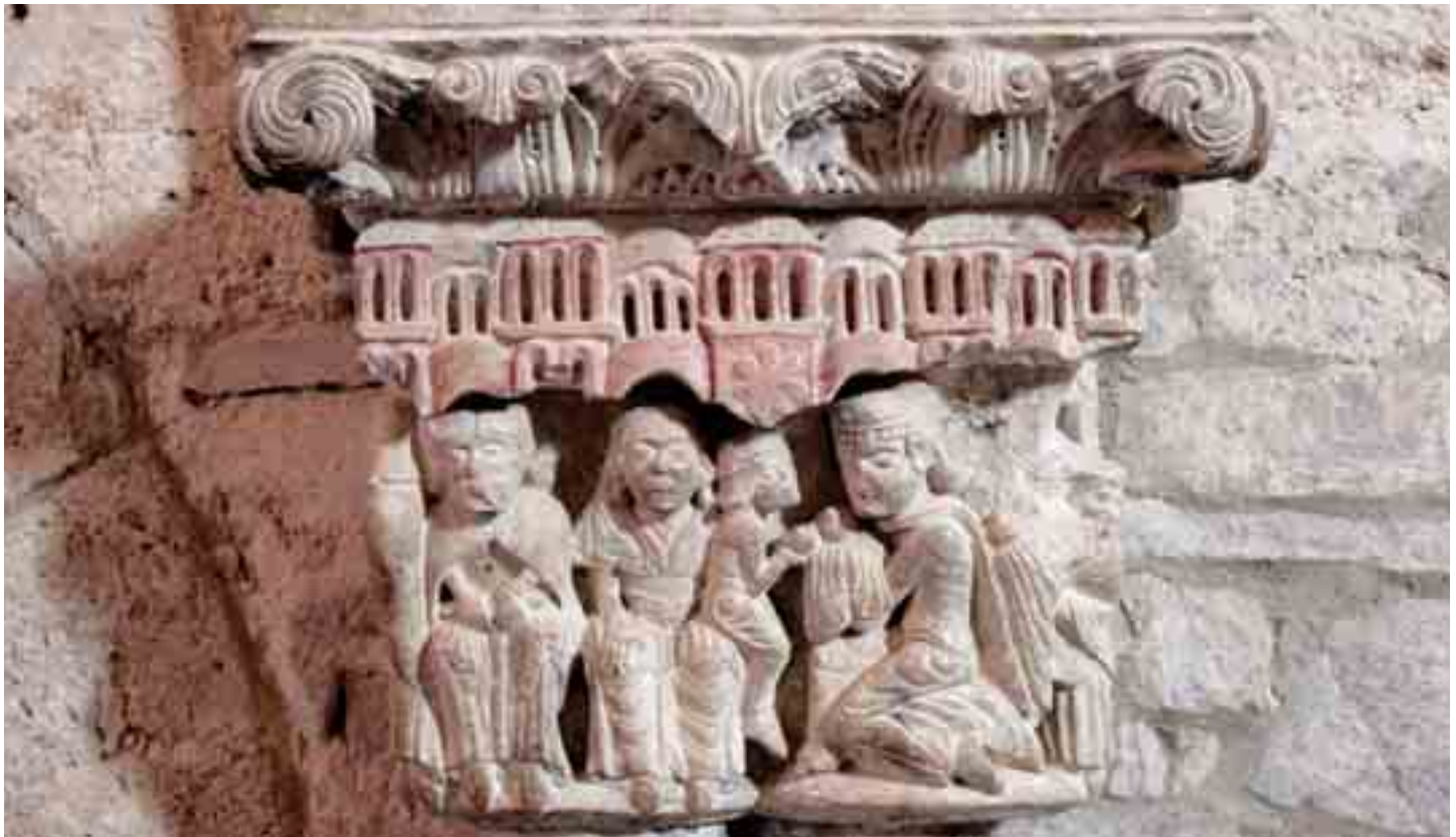
Capitel central de la arquería del presbiterio, lado del evangelio
