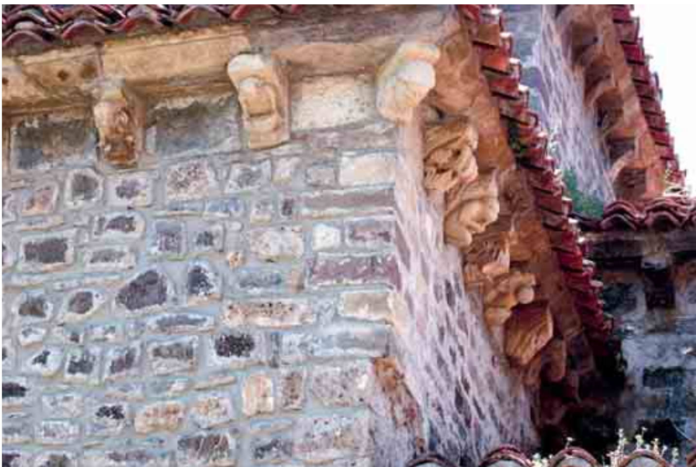
Canecillos del transepto norte, lados norte y oeste
