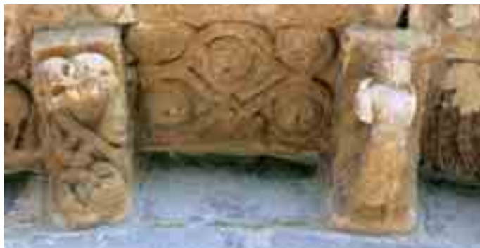
Canecillos 3 y 4, y metopa 4 del ábside central (lateral izquierdo o sureste)
