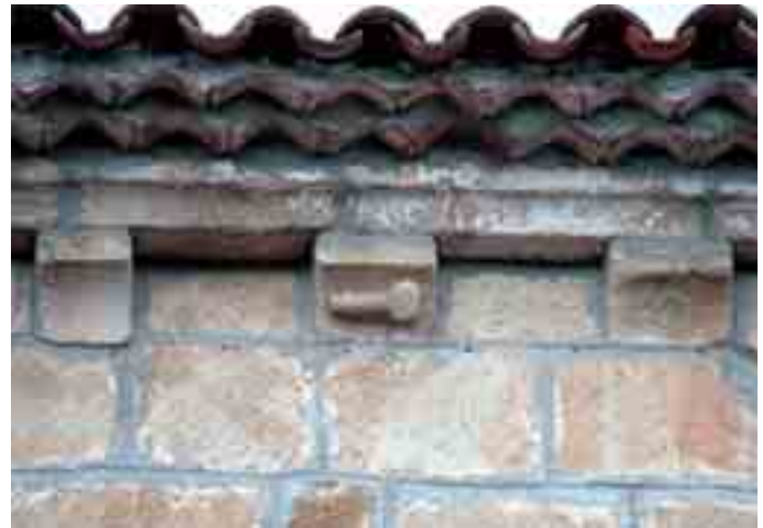
Canecillos de caveto y fállico del muro sur
