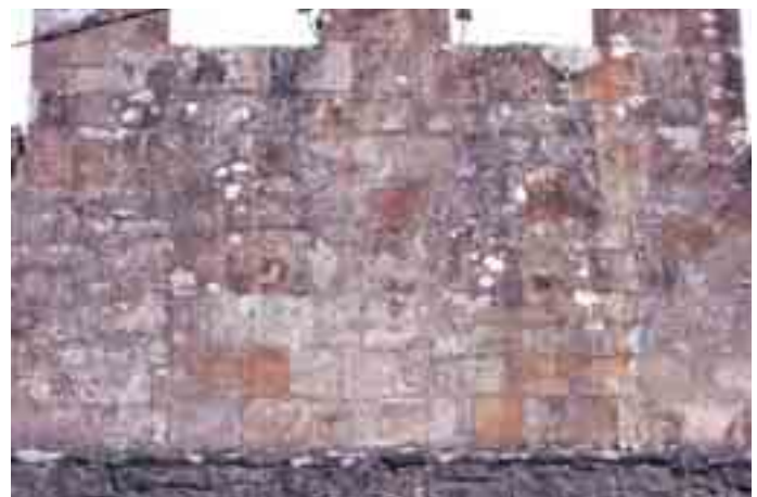
Arquerías tapiadas en el cuerpo alto de la espadaña
