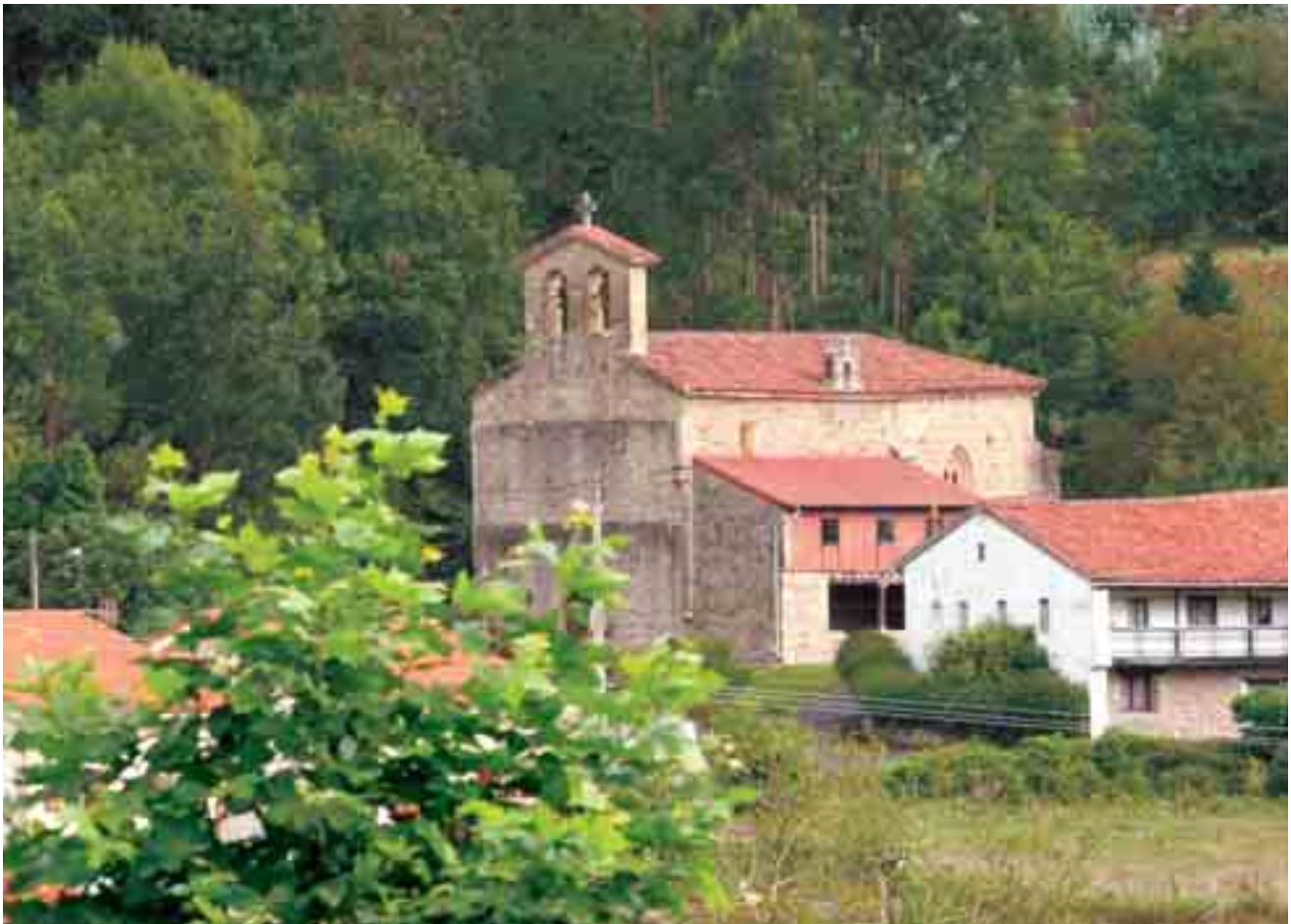
Vista general de la iglesia
