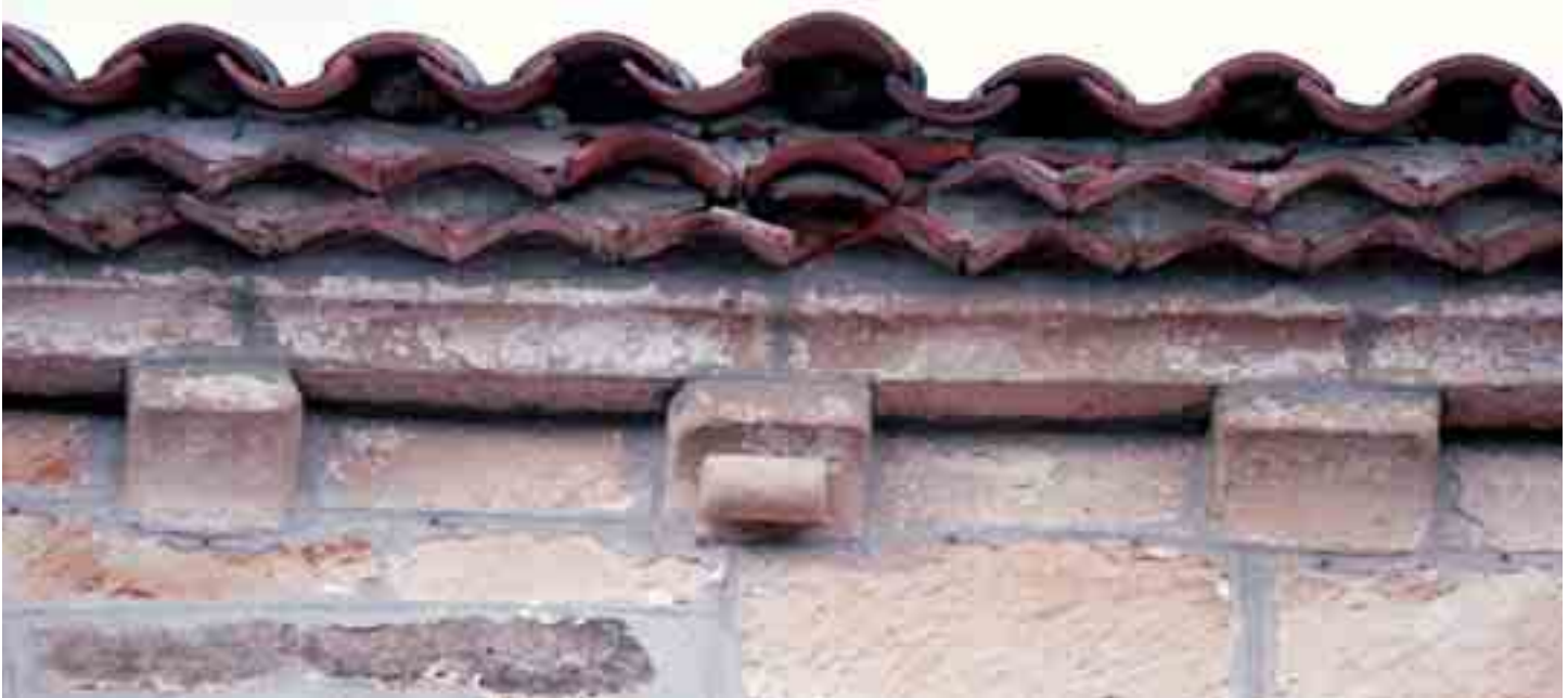
Canecillos de caveto y con rollo del muro sur
