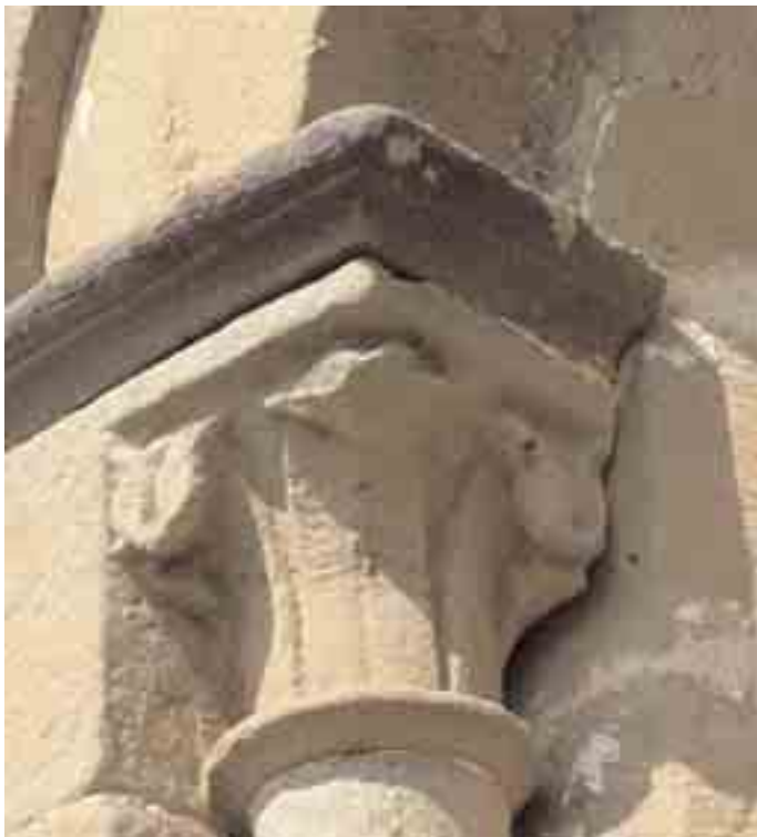
Cimacio y capitel izquierdo de la ventana central del ábside
