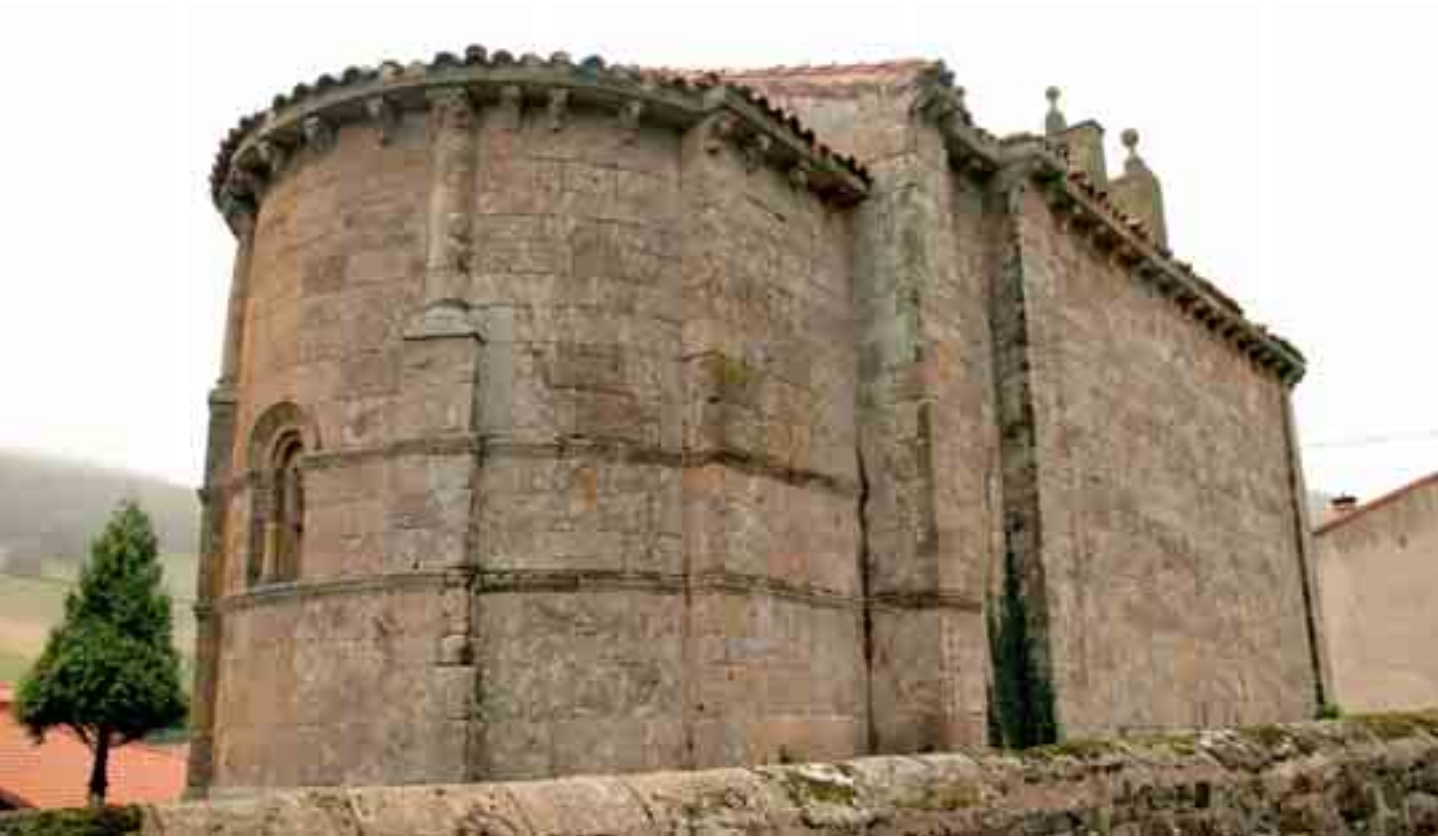
Vista del ábside, presbiterio y nave norte
