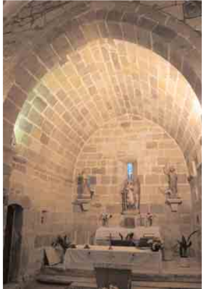
Interior del ábside y abovedamiento del mismo
