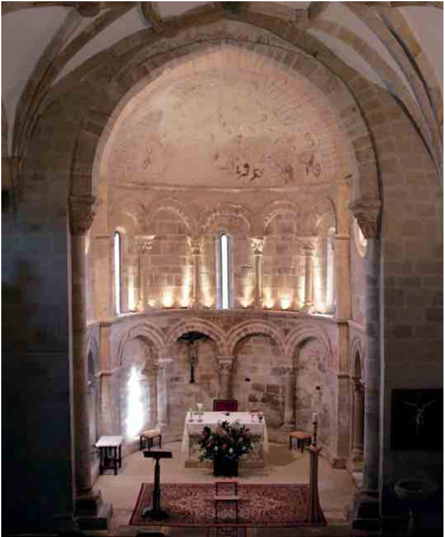
Cabecera del interior de la iglesia
