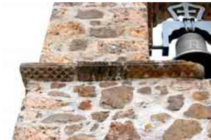
Detalle de la espadaña de la ermita de Santa Catalina
