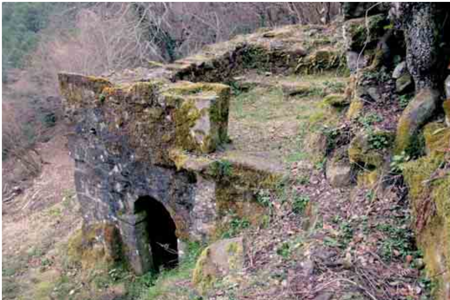
Aspecto exterior de la Cueva Santa, después de su restauración
