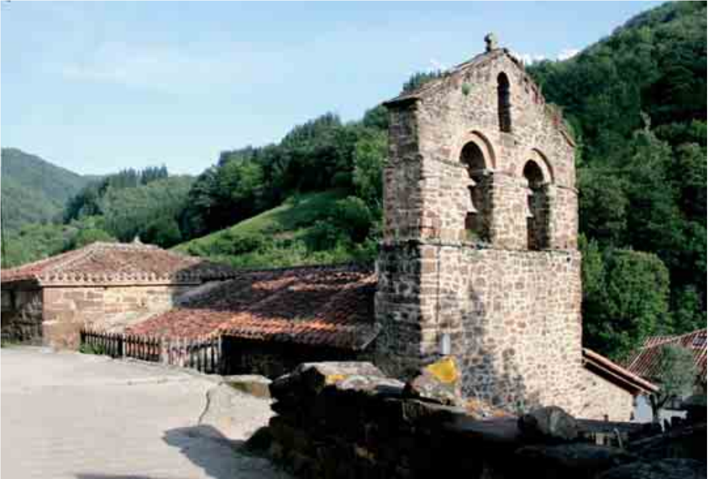
Espadaña con tres troneras
