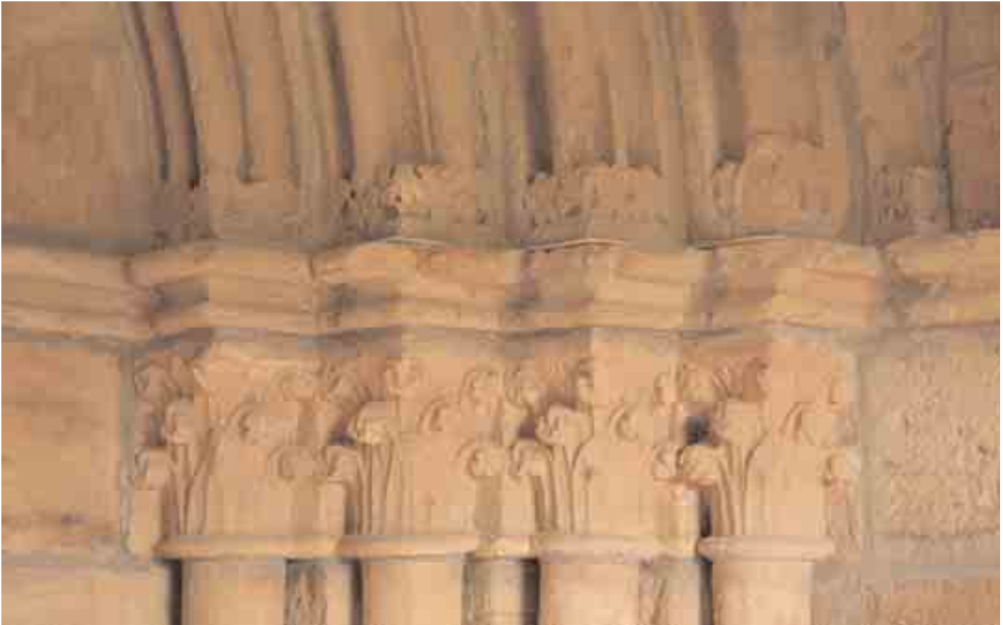
Detalle del lateral derecho de la puerta de entrada del muro meridional
