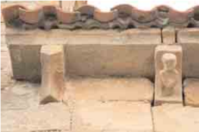
Canecillos 1 y 2 de la cornisa de la puerta del pórtico meridional
