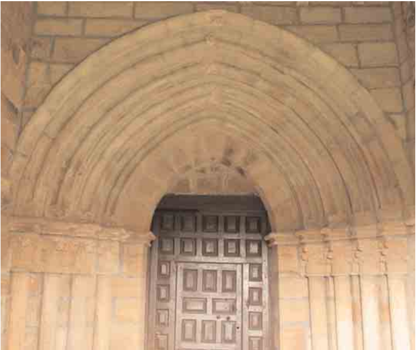
La puerta solemne de entrada a la iglesia en el muro meridional
