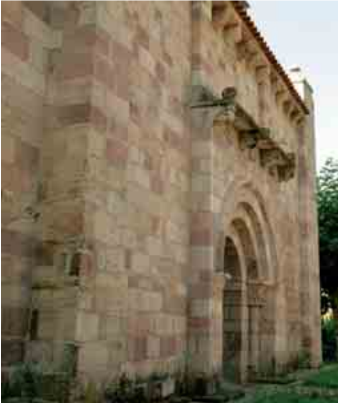
Puerta con cornisa
