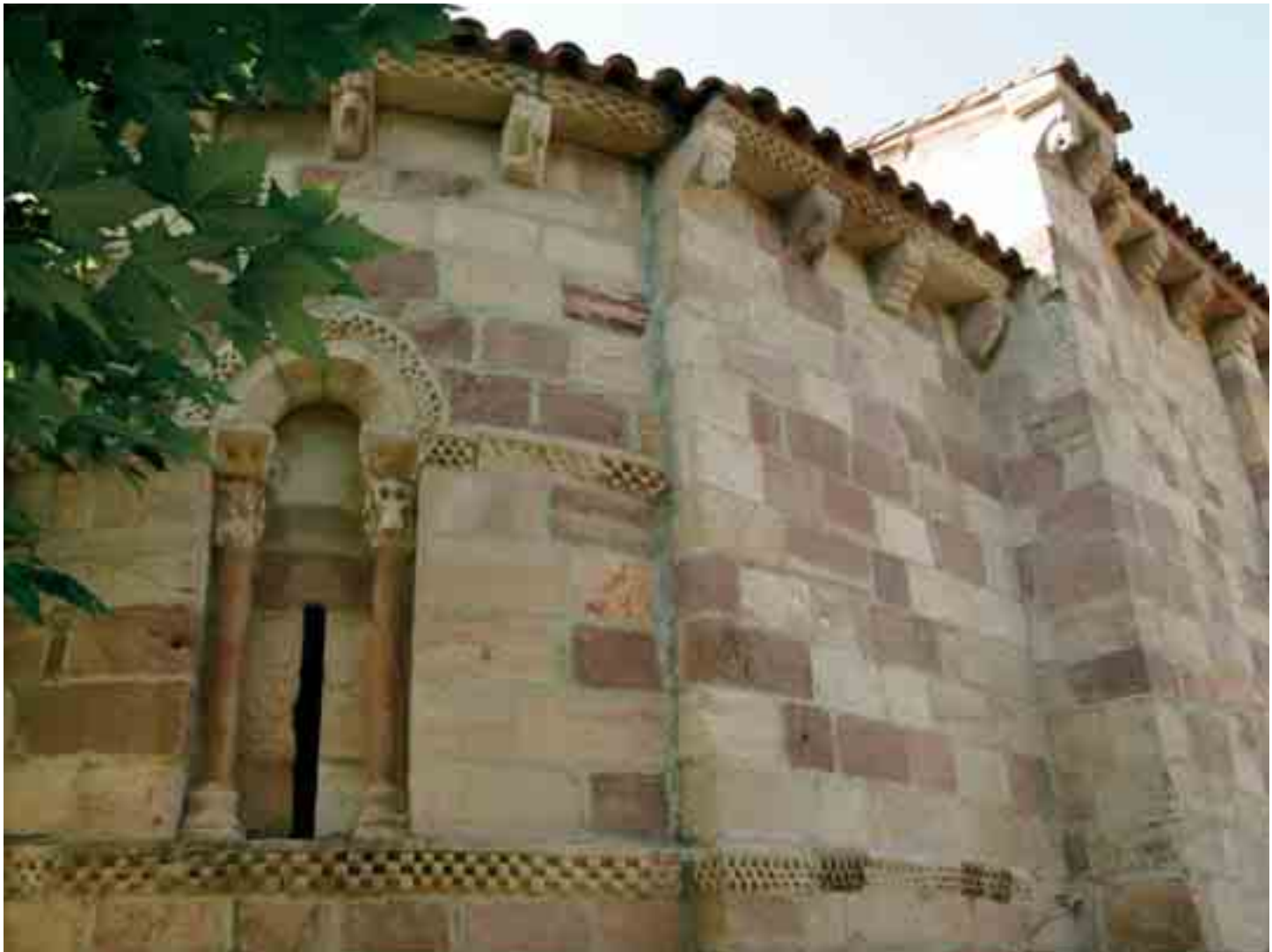
Ventana norte del ábside
