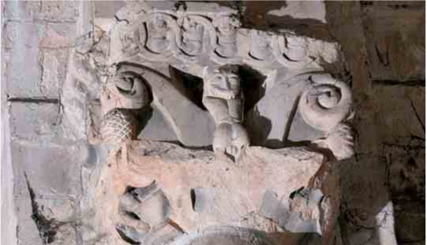
Capitel izquierdo del arco triunfal. Cimacio de leoncillos en el dintorno de círculos, y cara central de la cesta
