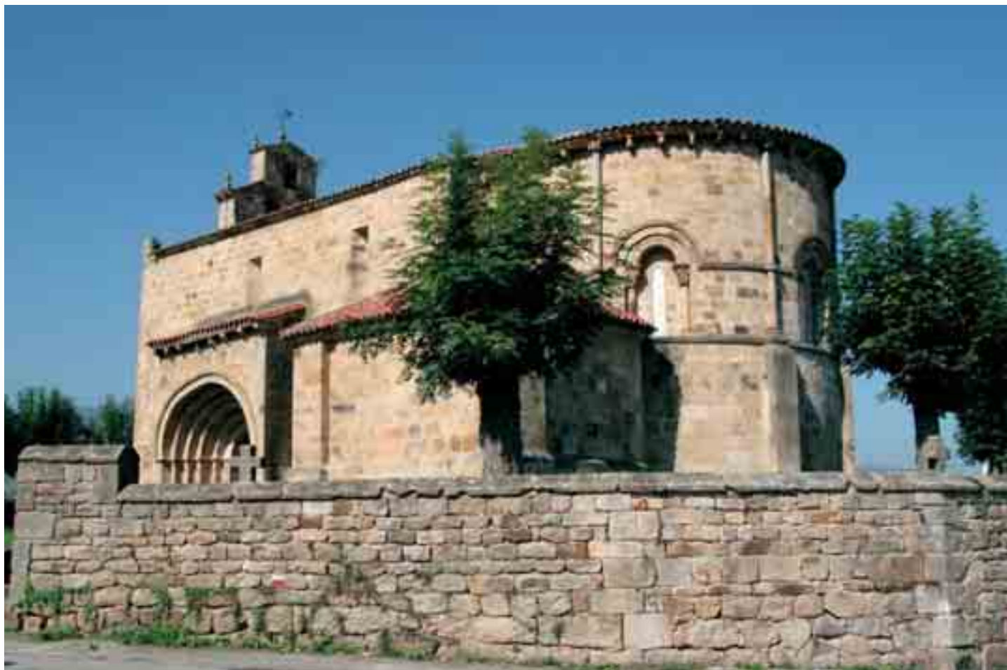
Vista de la iglesia desde el Sureste
