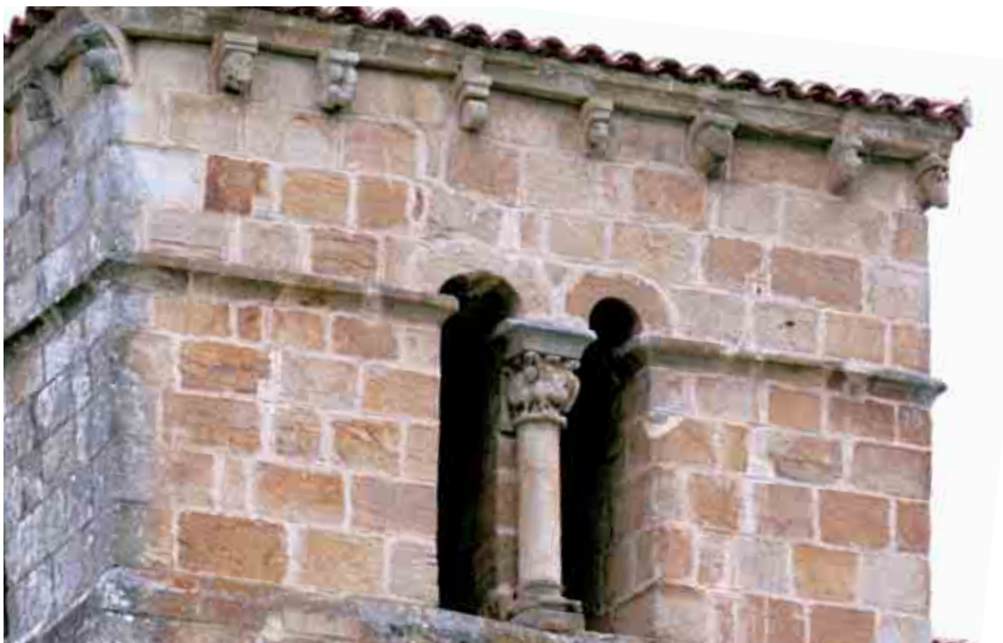
Ventanal ajimezado del muro sur de la torre
