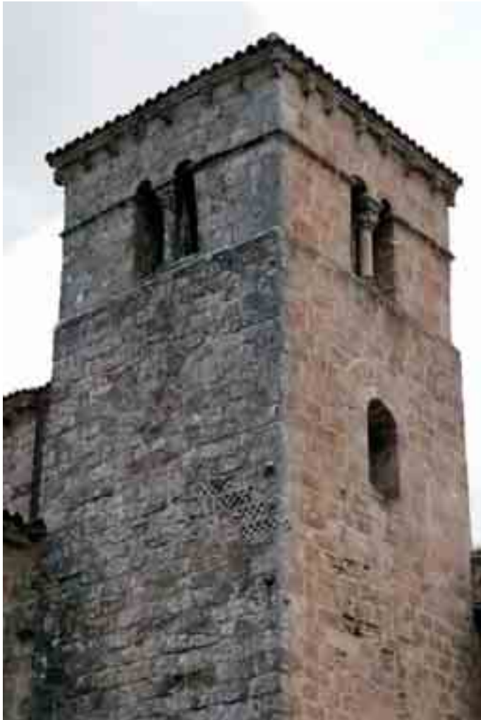
Lados oeste y sur de la torre
