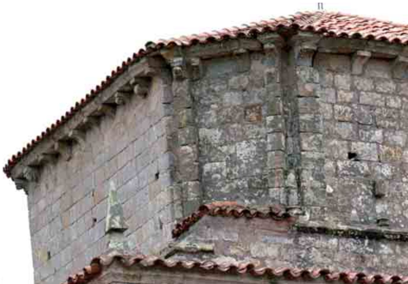
Linterna. Chaflán noroeste y muro norte
