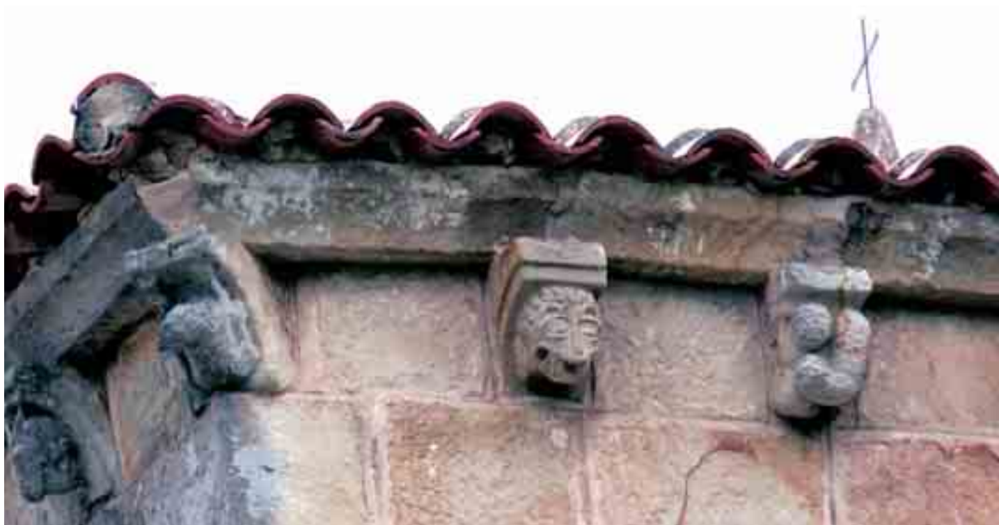
Detalle de algunos canecillos del muro sur de la torre
