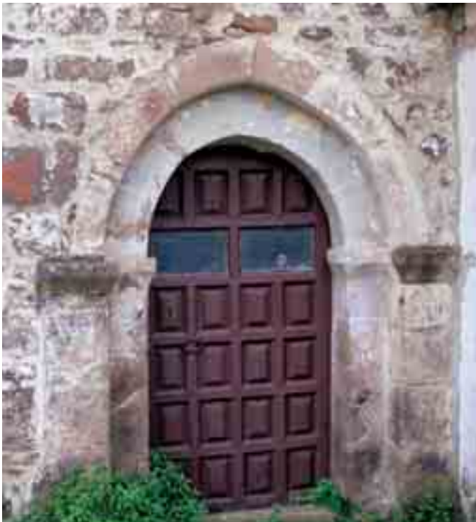
Puerta de acceso a la torre
