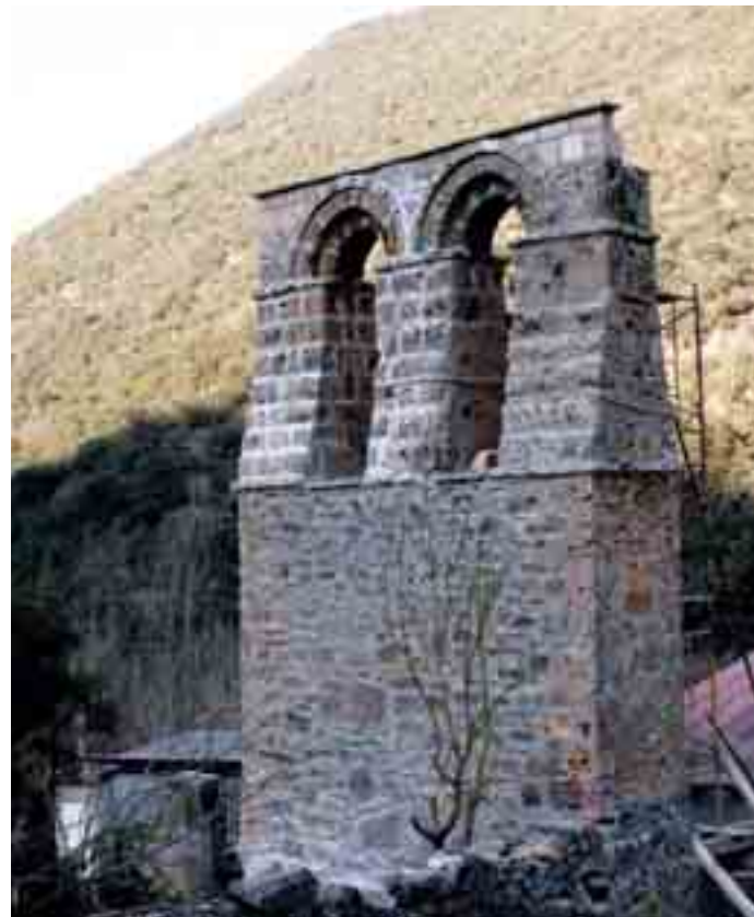
Espadaña durante su restauración
