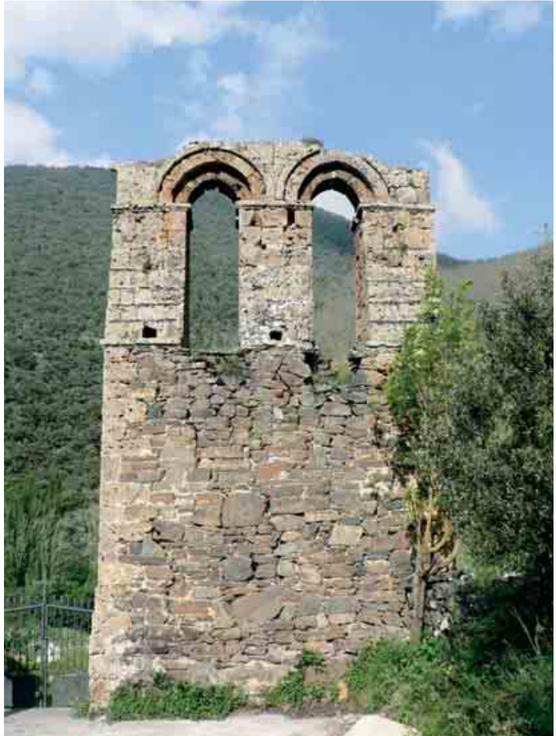
Espadaña del cementerio, antes de su restauración
