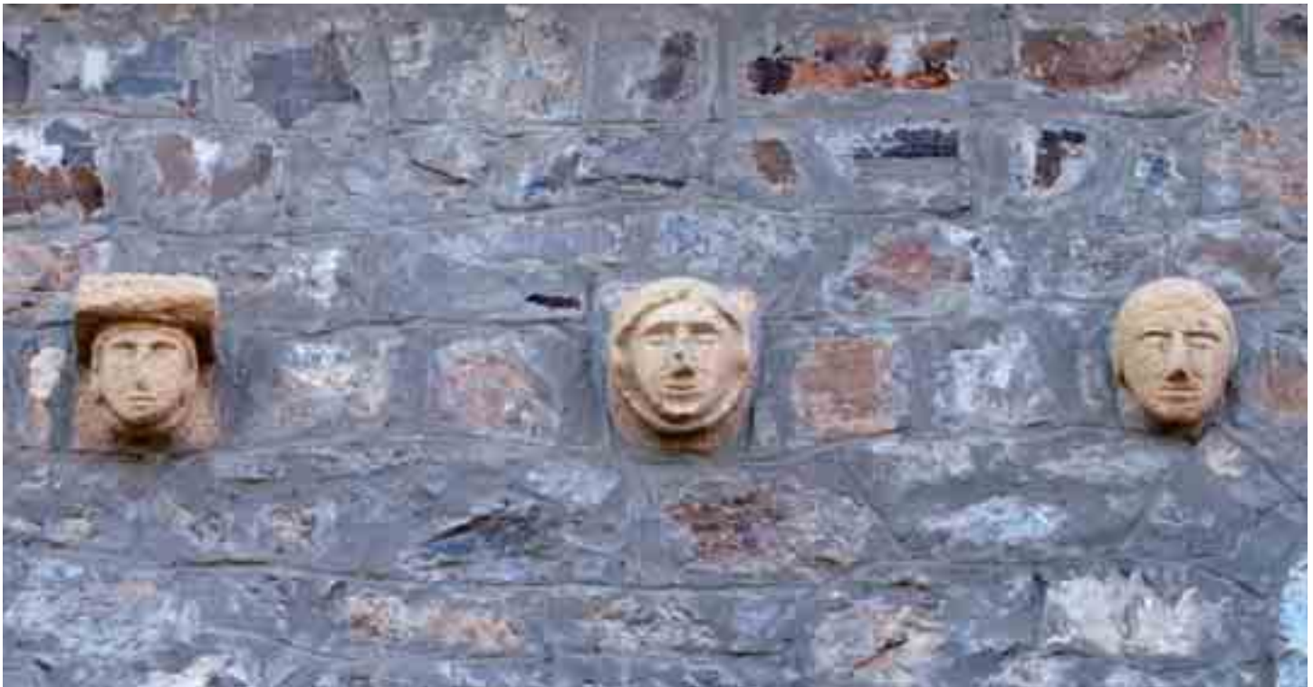
Canecillos recolocados en el muro de la iglesia nueva
