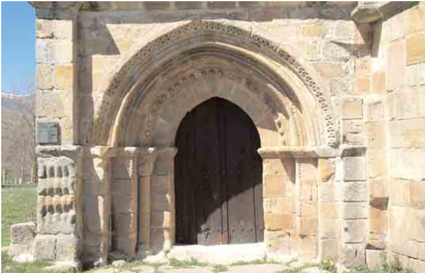
Puerta. Estuvo en el muro meridional
