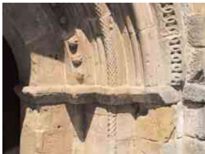
Detalle de la puerta. Lateral derecho
