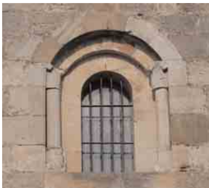
Ventana del muro occidental (espadaña), con restos de capiteles románicos
