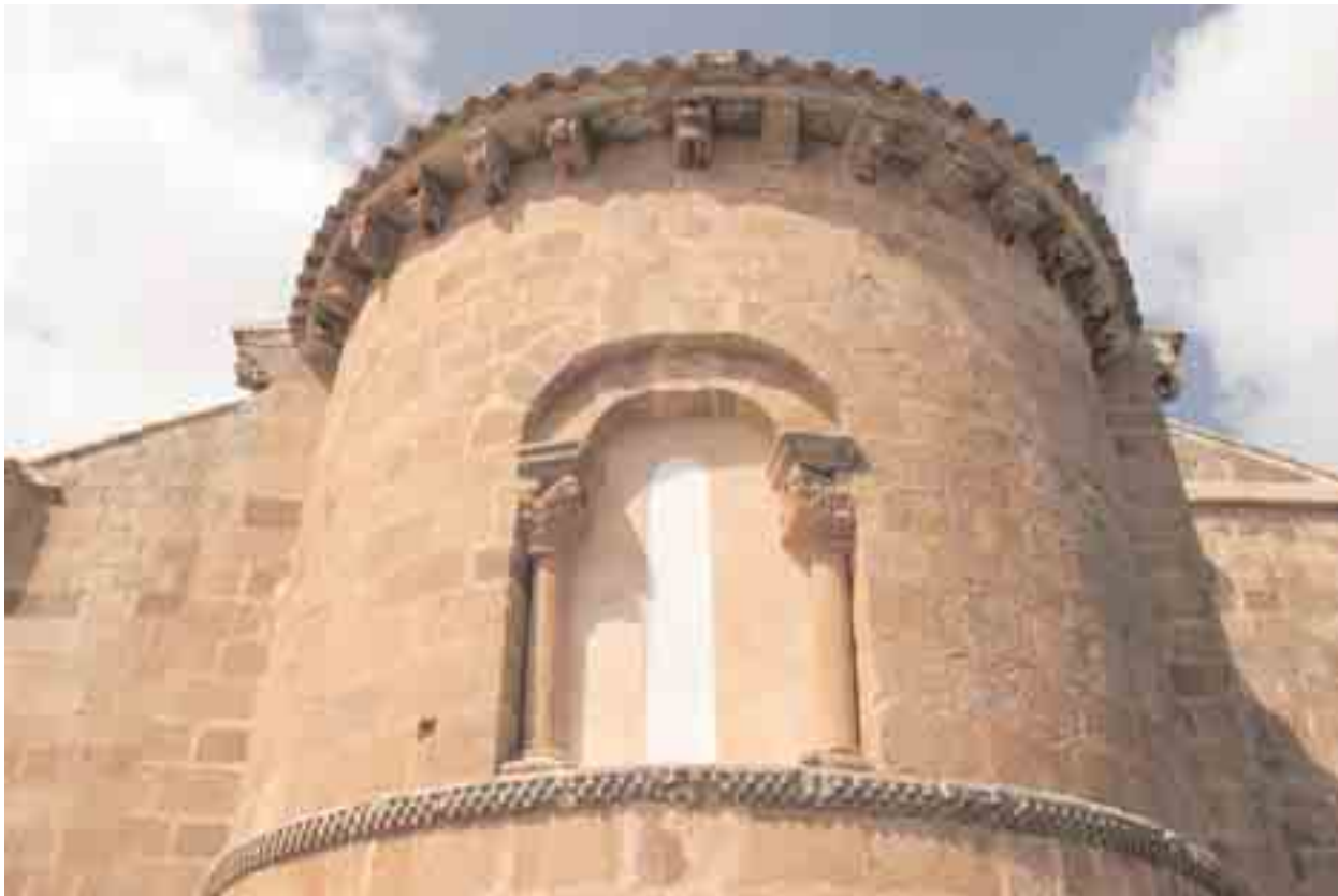
Ventana exterior del ábside. Conjunto
