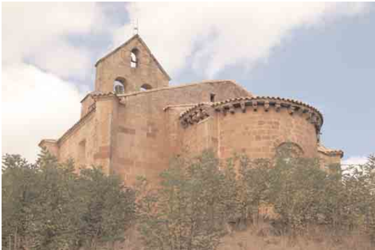
Aspecto de la iglesia desde el sureste
