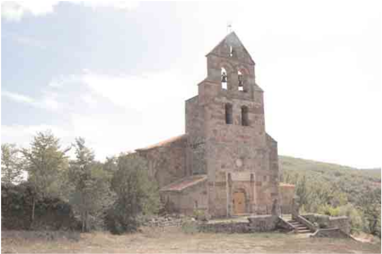
Aspecto de la iglesia desde occidente
