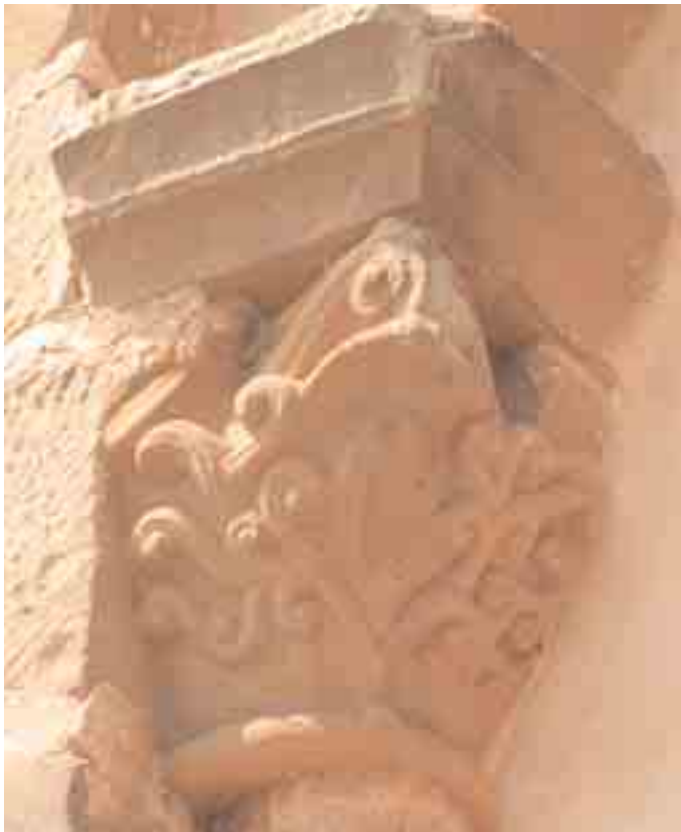
Capitel izquierdo de la ventana central del ábside
