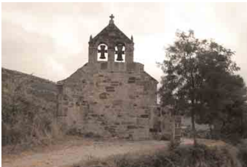
Vista del exterior de la iglesia desde occidente
