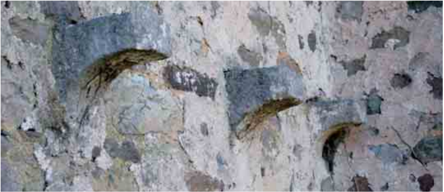
Canecillos del muro
