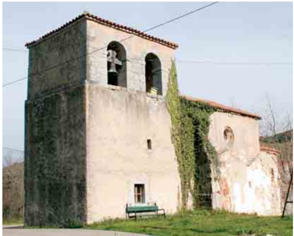
Vista exterior desde el Oeste
