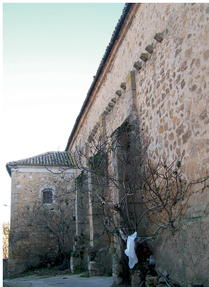
Hilera de canecillos en el muro norte
