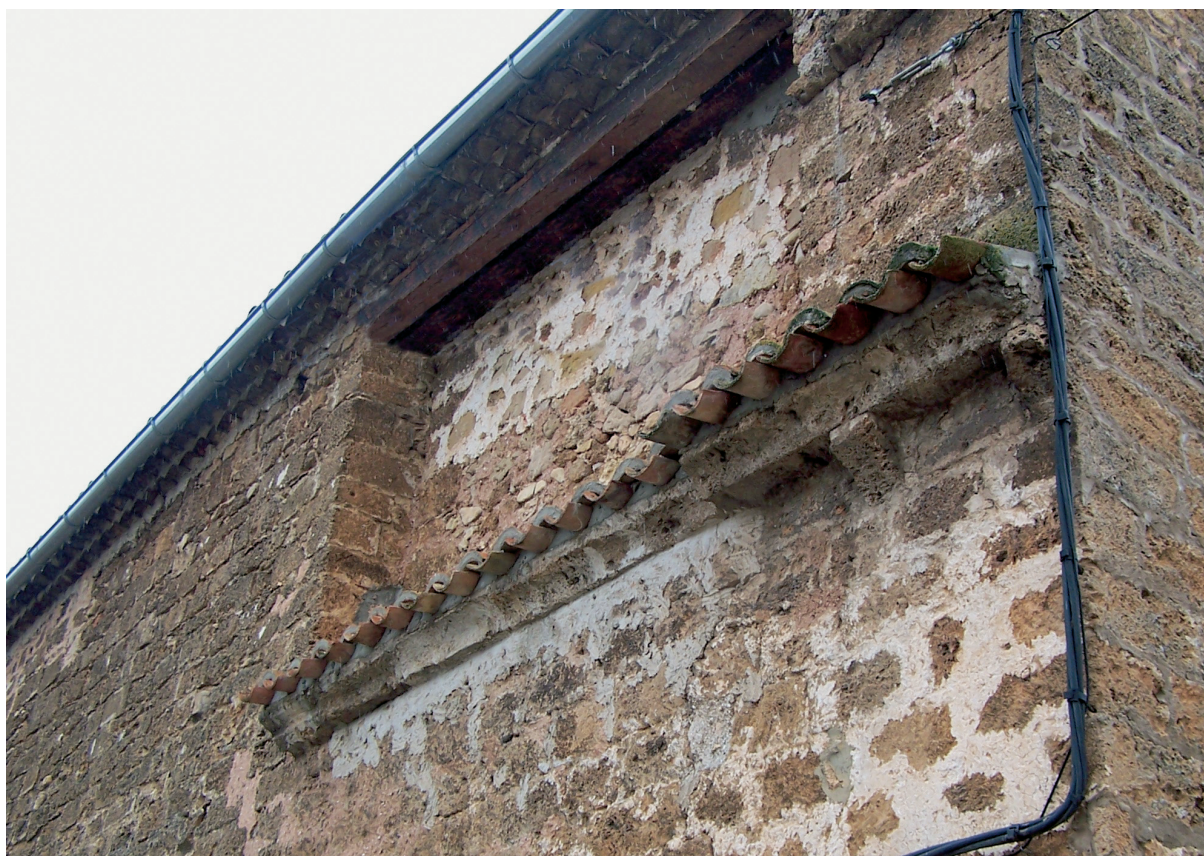
Canecillos del muro norte
