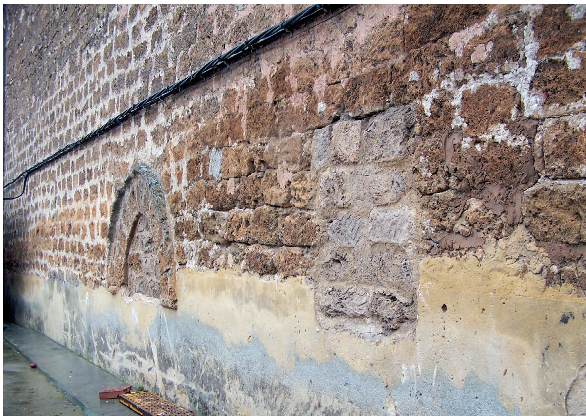
Arco del muro norte
