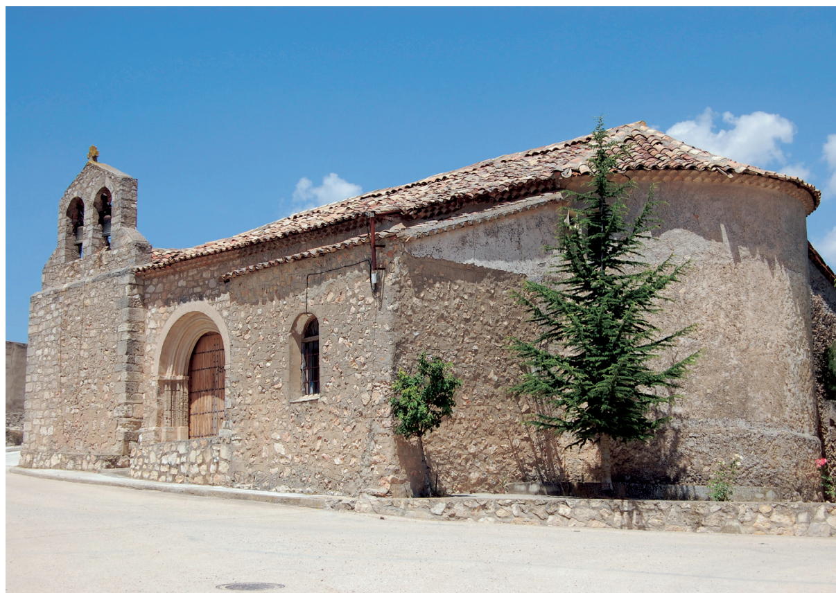
Vista desde el lado sureste
