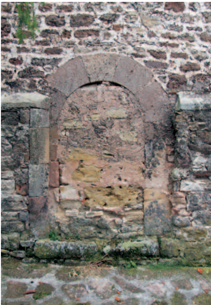
Puerta cegada del muro norte
