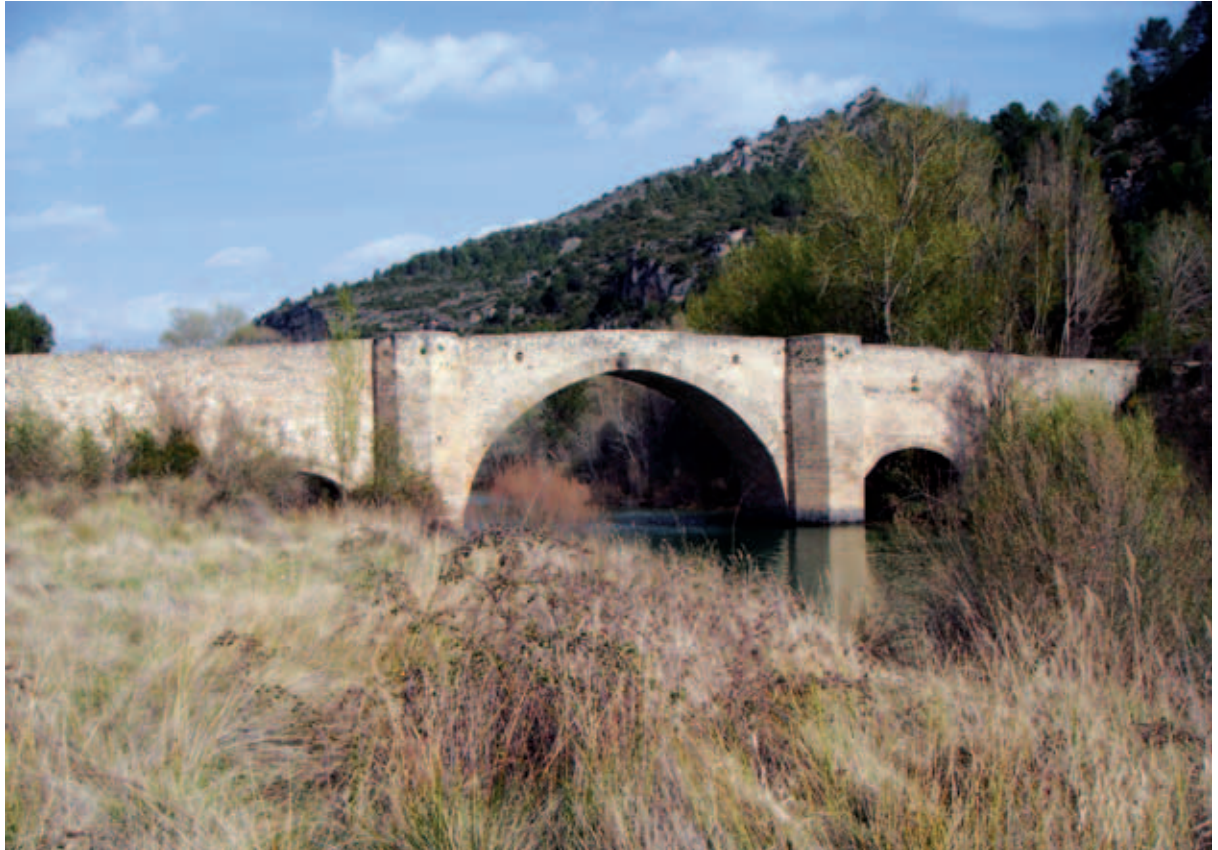
Puente de Auñón. Vista aguas abajo
