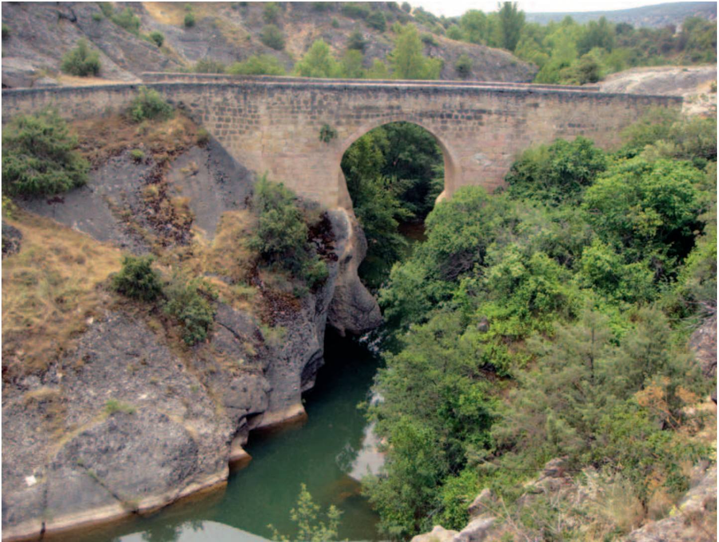
Vista del puente aguas arriba
