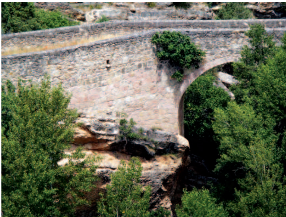
Vista aguas abajo, donde se aprecian las distintas reformas
