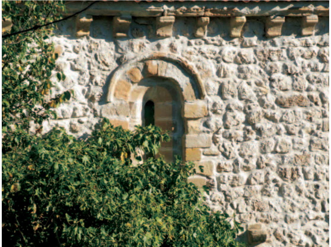
Ventana del muro sur
