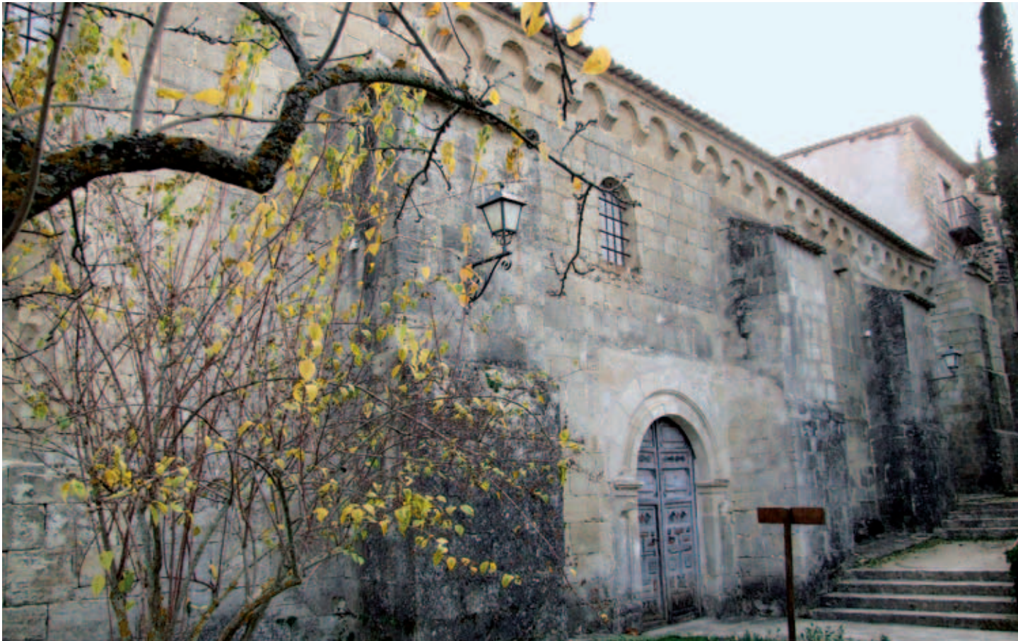
Muro norte de la iglesia
