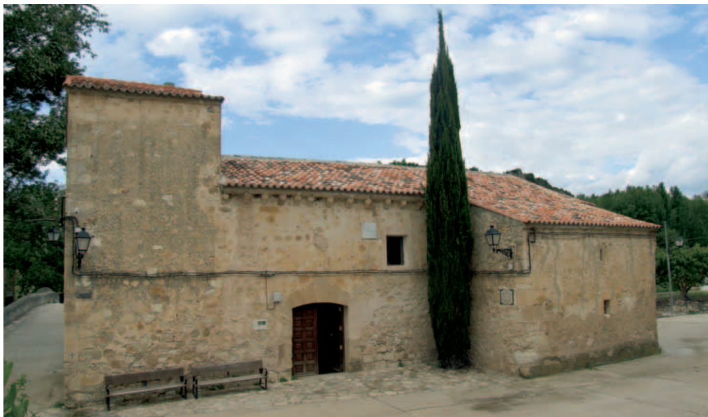
Exterior. Vista sur
