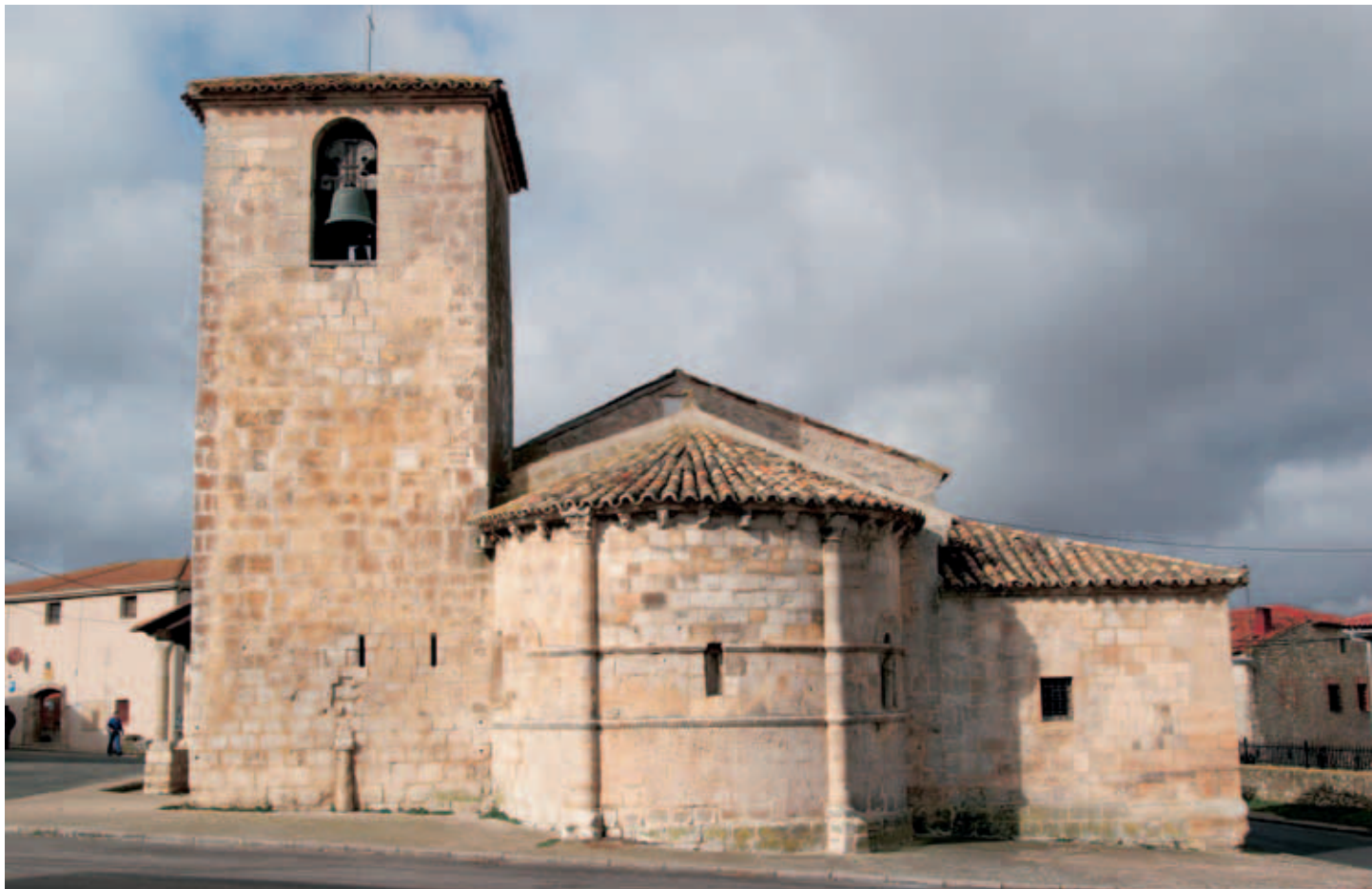
Ábside y torre
