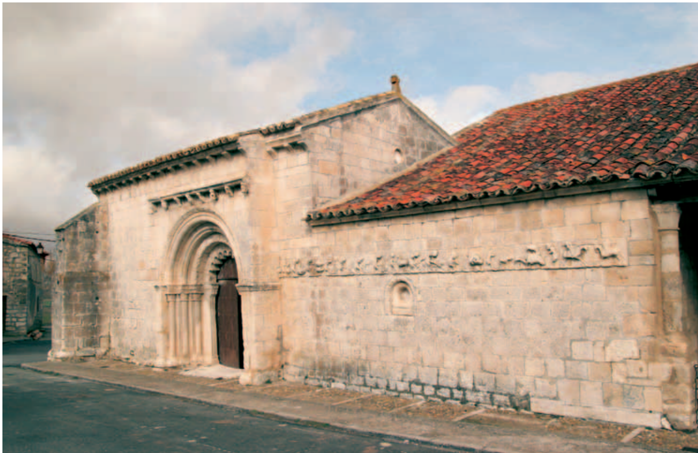
Vista general de la capilla de San Galindo
