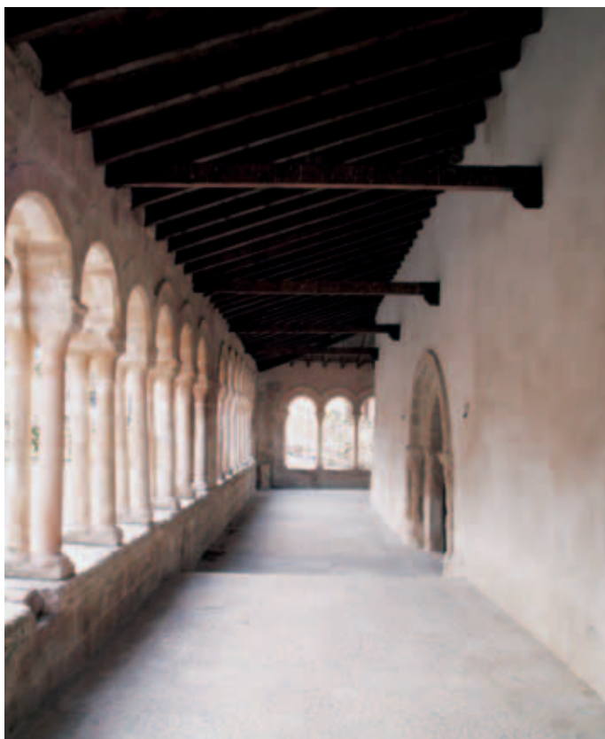
Interior del pórtico
