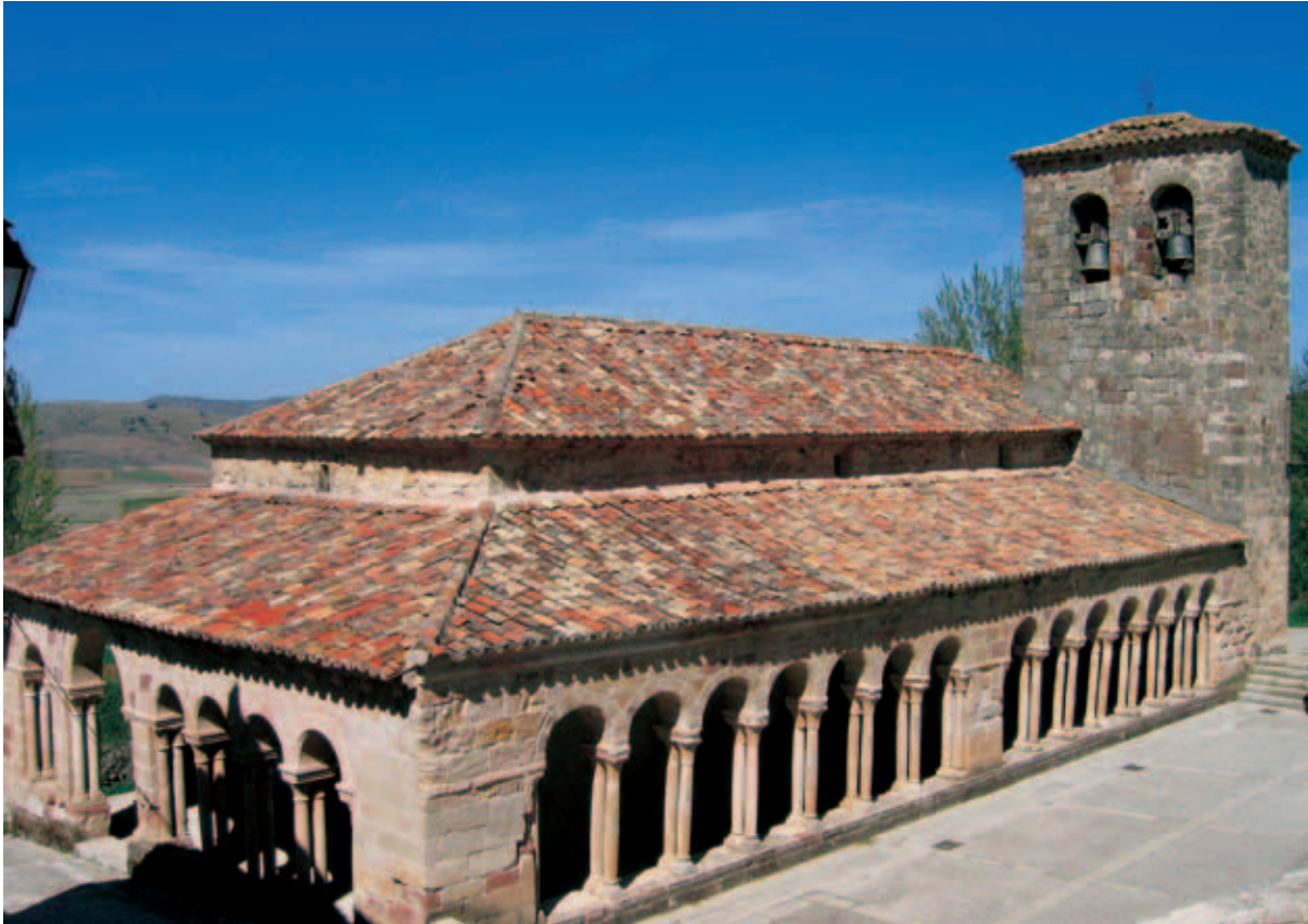
Vista general de la iglesia
