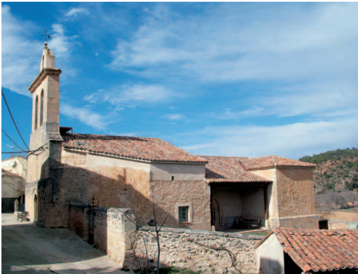
Vista exterior de la iglesia
