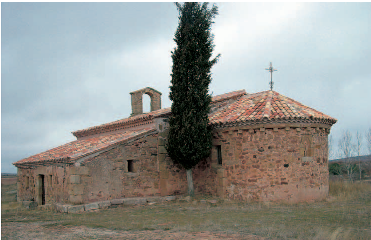
Vista general de la iglesia
