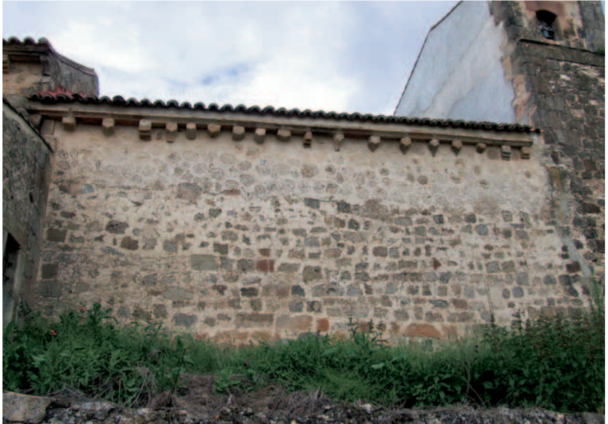
Muro norte de la nave
