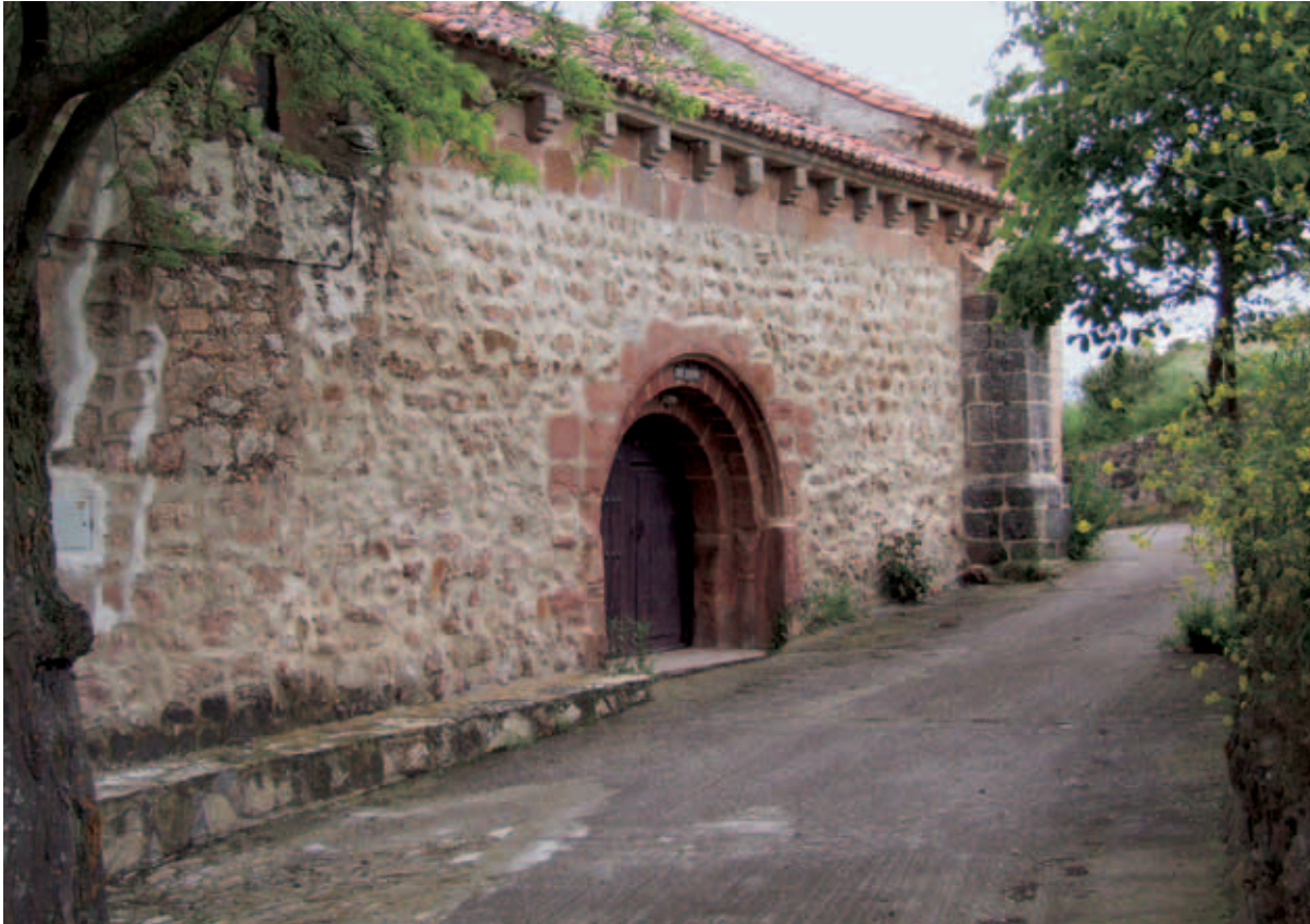
Vista del muro sur
