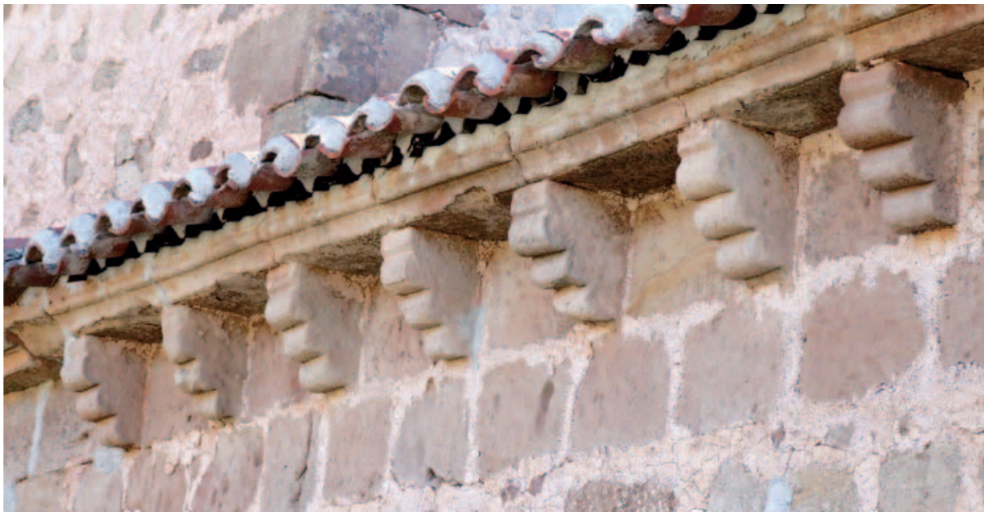
Canecillos en el muro norte
